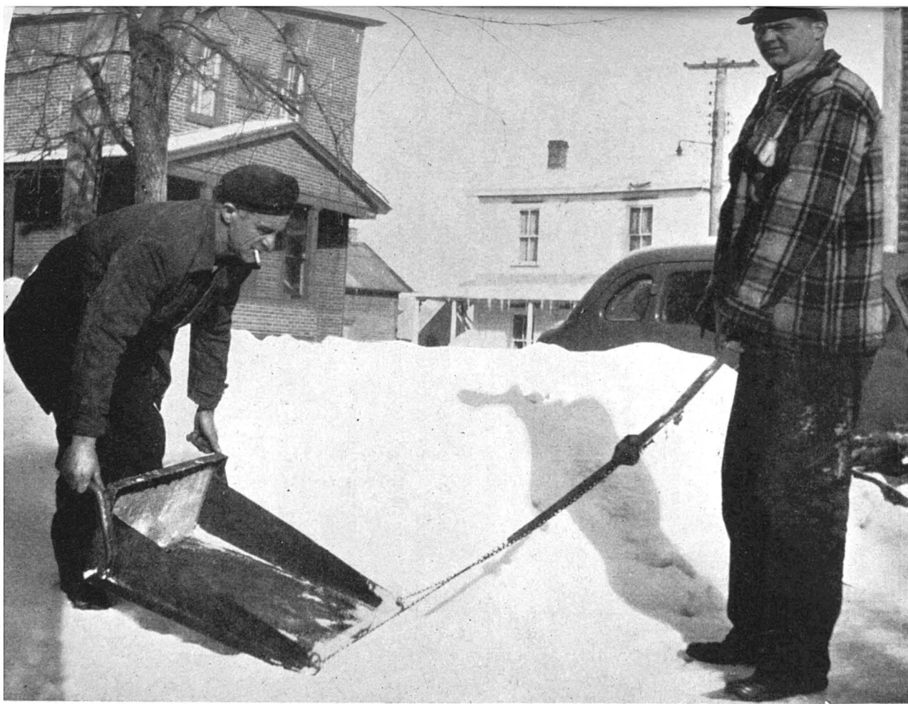
FIGURE 9.— Façon de manipuler la drague illustrée dans la Figure 8. (Photo par H. Durand).
