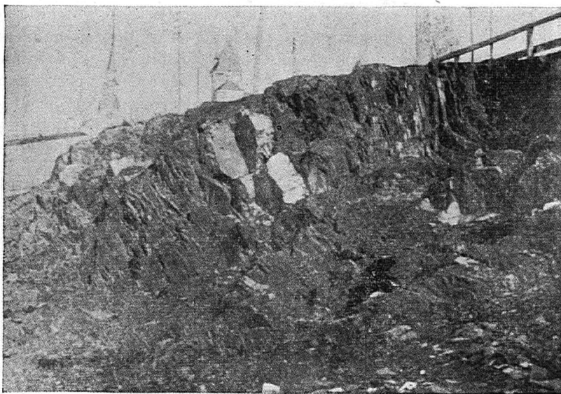
FIGURE 8.—L'ancien affleurement en arrière du Palais Montcalm. Reproduction d'une photographie de 1890 publiée par Weston en 1899.
