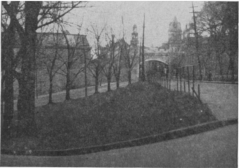
FIGURE 7.— Etat actuel de l'affleurement en arrière du Palais Montcalm. Photographie: R. Bureau (1944).
