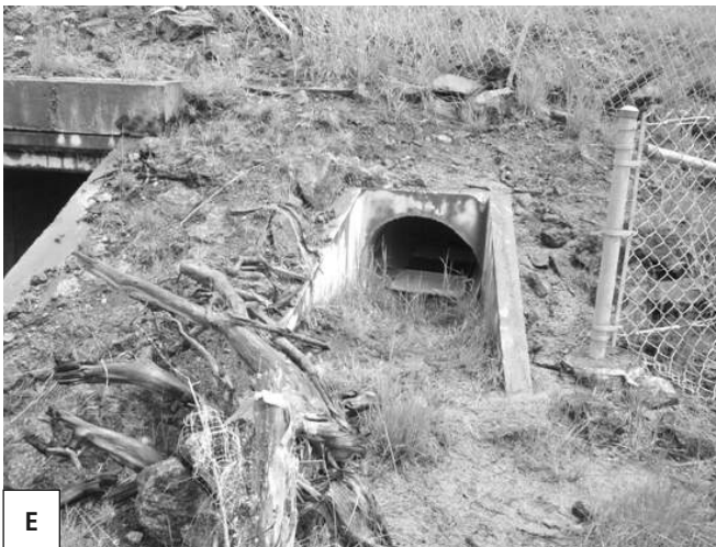
Figure 2. Différents types de passage à petite faune utilisés dans la réserve faunique des Laurentides : A) aménagement du lit majeur, B) marche, C) tablette en porte-à-faux installée sur un ponceau existant, D) tablette en porte-à-faux préfabriquée, E) tuyau de béton armé et F) muret de type New-Jersey troué pour le passage de la petite faune.
