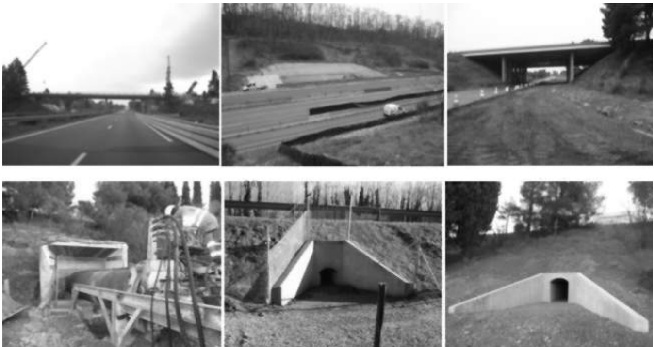
Figure 4. Aménagements en cours de réalisation sur le réseau ASF (Cédric Heurtebise, direction technique de l'infrastructure, comm. pers.).
