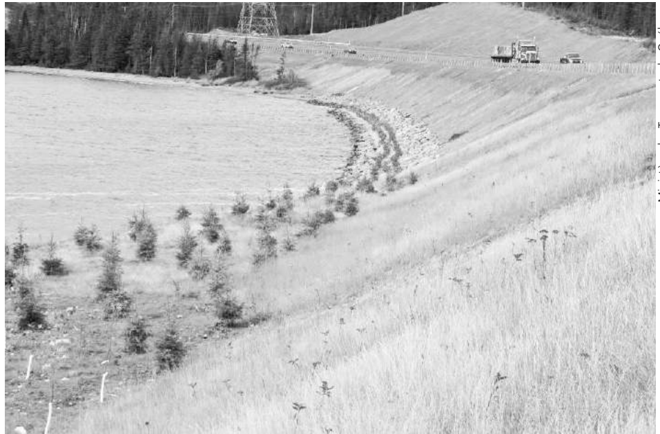
Figure 3. Talus ensemené et planté. Préalablement aux interventions de végétalisation, le talus était entièrement composé de roc dynamité. Ici, le remblai a été prolongé au niveau de la berge pour recréer l'écotone riverain.
