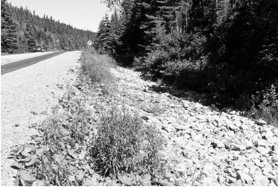
Figure 4. Le drainage et l'empierrement des mares salines sont des mesures d'atténuation des accidents routiers avec l'orignal.
