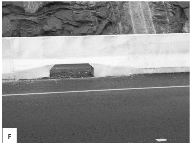
Figure 2. Différents types de passage à petite faune utilisés dans la réserve faunique des Laurentides : A) aménagement du lit majeur, B) marche, C) tablette en porte-à-faux installée sur un ponceau existant, D) tablette en porte-à-faux préfabriquée, E) tuyau de béton armé et F) muret de type New-Jersey troué pour le passage de la petite faune.
