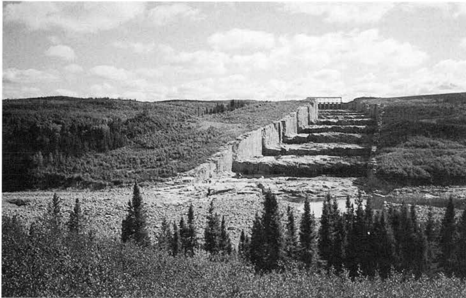
Déversoir de barrage
