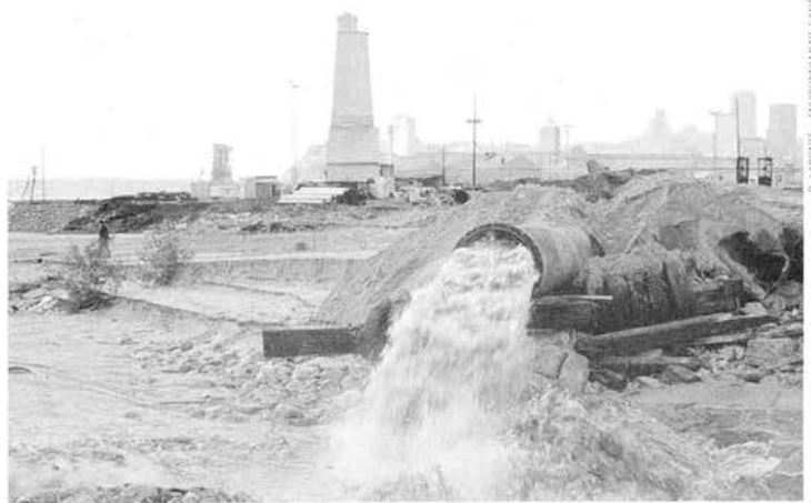
Port de Québec – Embouchure du tuyau de la drague hydraulique qui déverse les déblais sur la batture de Beauport (1977).
