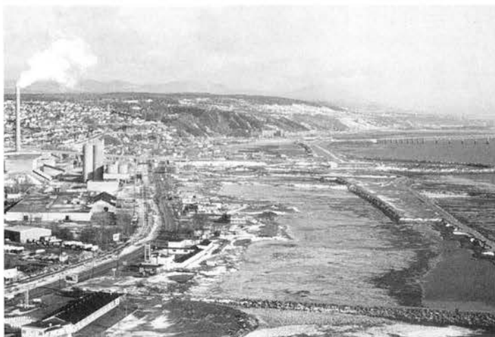
Battures de Beauport – Remblayage des battures avec les sédiments dragués au port
