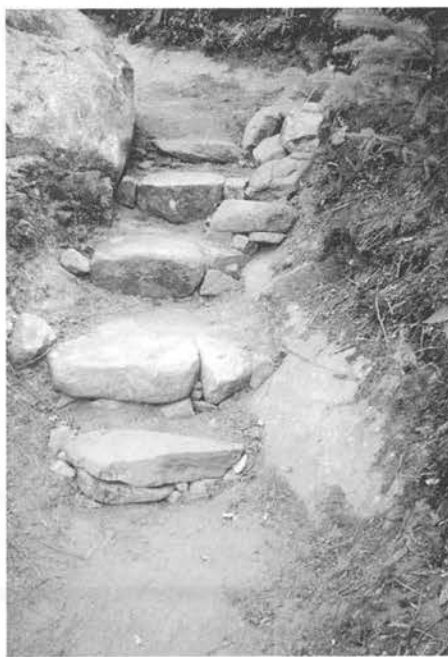
L'aire de marche avant et après l'aménagement d'un escalier de pierres.
