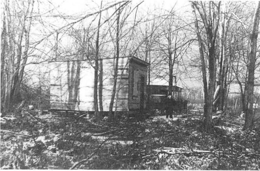
**Figure 4 – Photographie 2 : «R. Montpetit property, looking east, showing location of building in a permanent swamp, construction on piles and alteration of natural conditions». Cette photographie est indiquée sur le plan de Marcel Cailloux, avec un angle de vision.**
