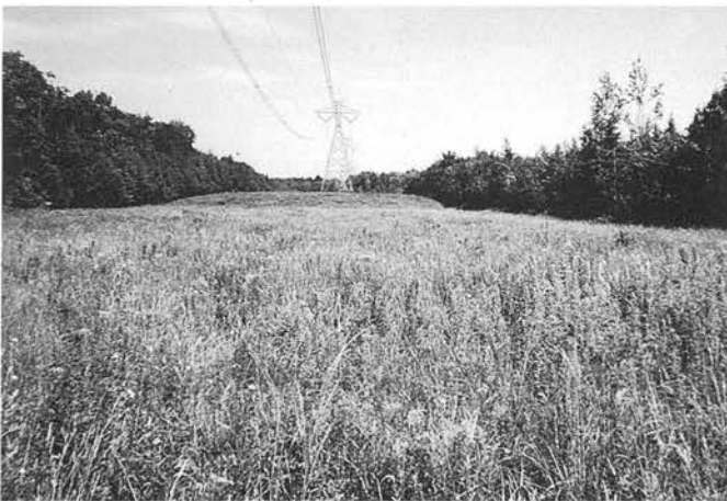
Figure 3. L'emprise aménagée de Watopeka a été essouchée, nivelée et ensemencée de graminées et de légumineuses.
