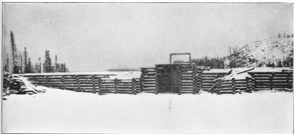
Réservoir d'eau, rendu nécessaire pour le flottage des billots, par la diminution du débit de la rivière.
