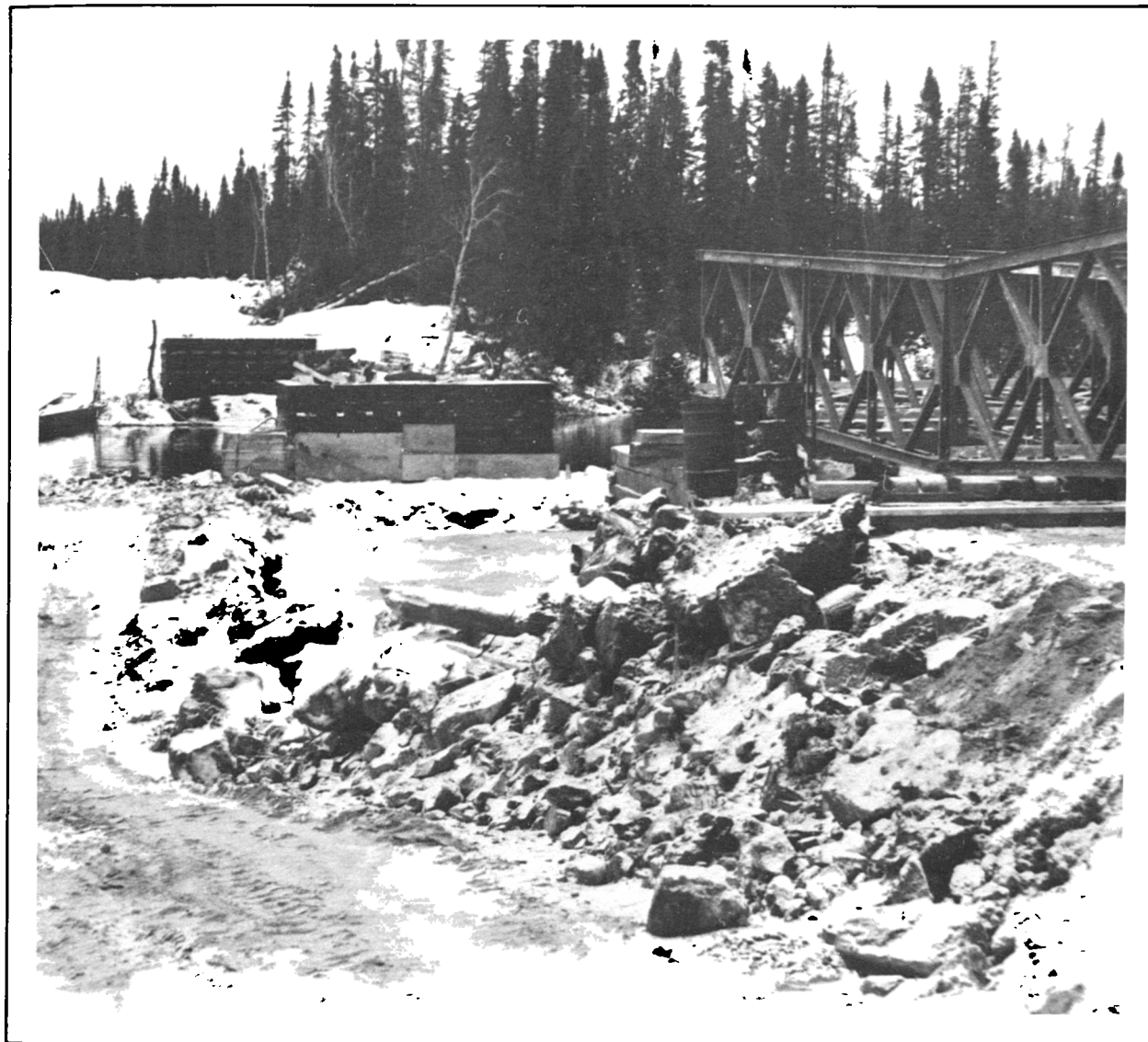
Figure 10 Érection d'un pont «Bailey» au détroit Gwillim — Saguenay — Lac St-Jean
