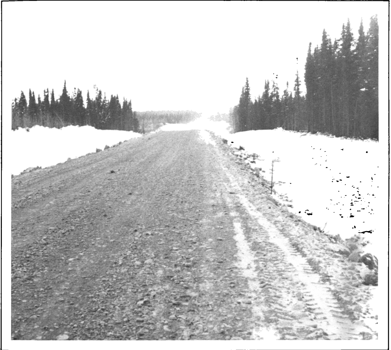
Figure 12 Accès permanent à la mine Doyon (Abitibi)
