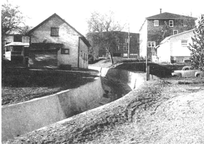
Canalisation du ruisseau Théberge à Saint-Eléphère, comté de Kamouraska.
