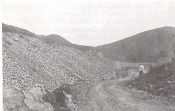
Quelques aspects des installations et des travaux en cours à la compagnie "Mines Madeleine Limitée", dans le parc de la Gaspésie (Photos OFQ)
