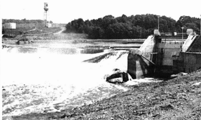
Le barrage anti-inondation à Bromptonville.
