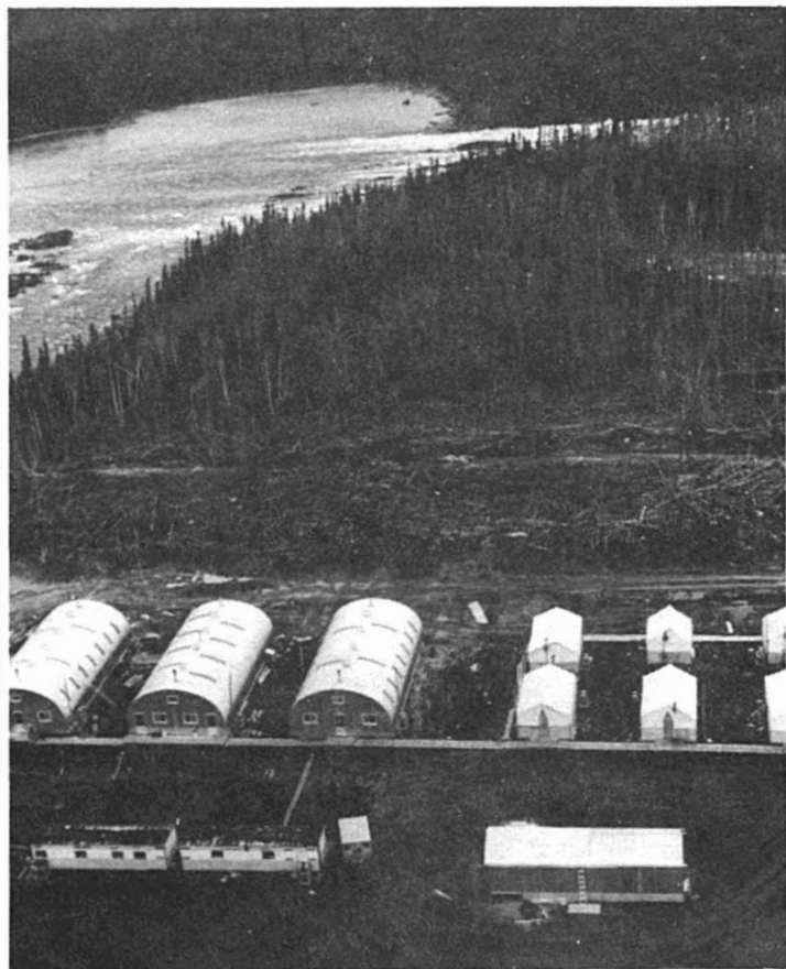
Vue partielle d'un camp typique où logent des centaines de techniciens, ingénieurs et manoeuvres engagés dans les travaux géants du bassin de la Baie James.
