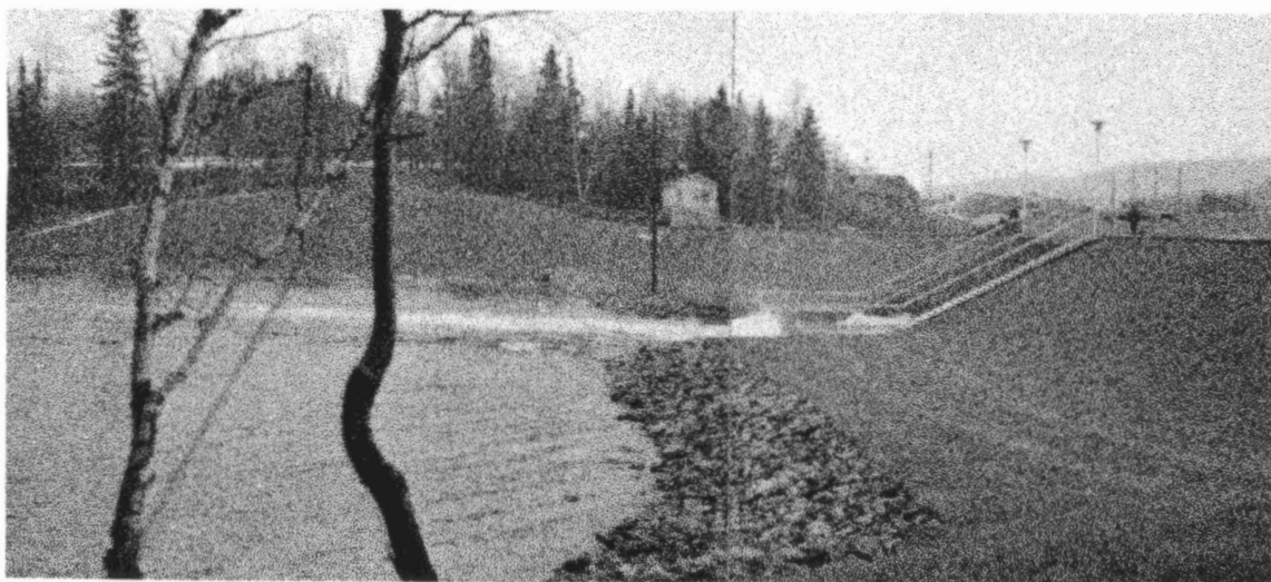
Aménagement de la partie aval au barrage du lac des Commissaires, comté de Roberval.
