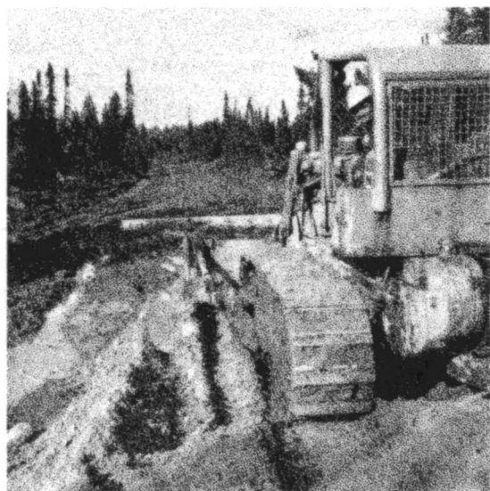
Chemin d'accès au lac Evans-construction en terrain marécageux.
