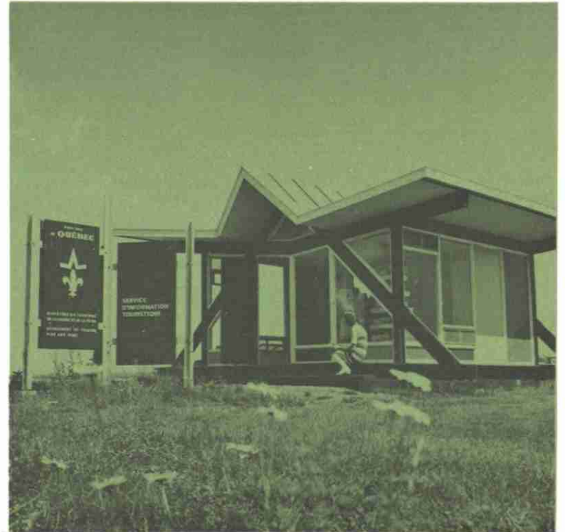
Le «Toit de l'hospitalité coiffant les kiosques d'accueil».
