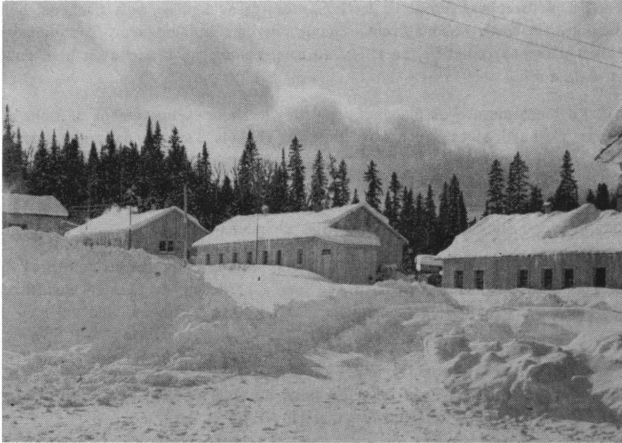
Un des 1,802 chantiers d'opérations forestières du Québec, dont l'ensemble des bâtisses s'élève à 10,146.
