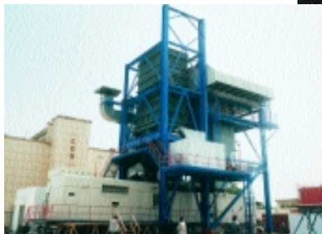
La construction et la mise en service de la centrale à turbine à gaz de Bel-Air, au Sénégal, d'une puissance de 37,4 MW, ont été réalisées avec la participation d'une entreprise québécoise et d'un partenaire sénégalais.
