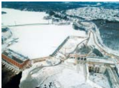
La nouvelle centrale de Grand-Mère, un chantier en milieu urbain.
