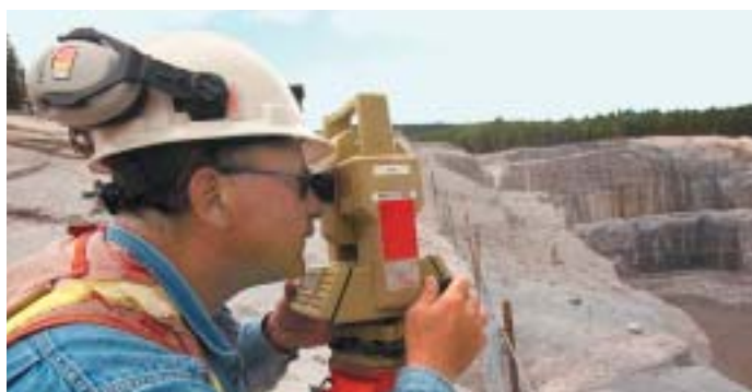
Travaux d'arpentage sur le site de la centrale de la Toulnostouc.
