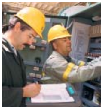
Fin des travaux de réfection de la centrale de Shawinigan-2.
