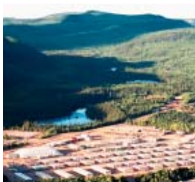
Construction de la centrale de la Toulnostouc: le campement des travailleurs.
