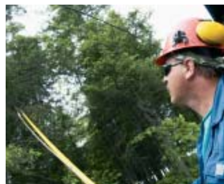
Travaux d'élagage pour prévenir les pannes.
