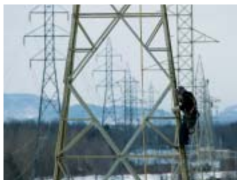
Construction d'une ligne à 120 kV entre Magog et Sherbrooke.
