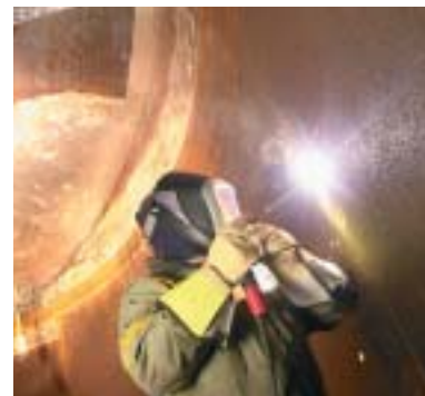
Travaux de réfection à la centrale de Beauharnois.
