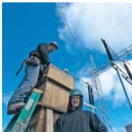
Au poste de Micoua, la construction des équipements de transport se poursuit.
