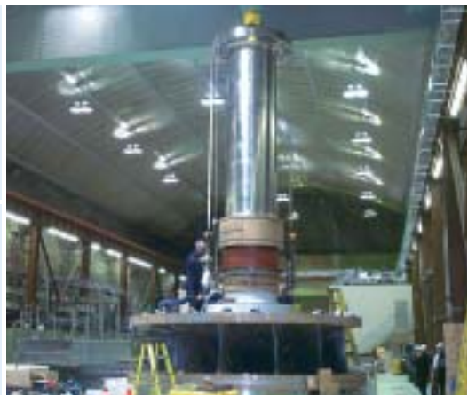
Centrale aux Outardes-3 (Côte-Nord). Elle fait l'objet d'importants travaux de réfection.
