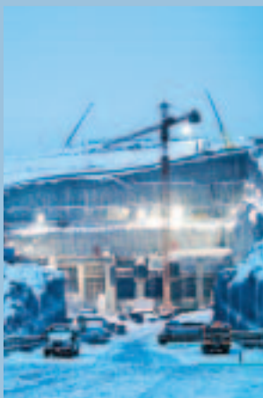
En couverture : Centrale de l'Eastmain-1. Vue du site de la future centrale à partir du canal de fuite. Ce canal acheminera l'eau depuis la sortie des turbines jusqu'à la rivière Eastmain.
