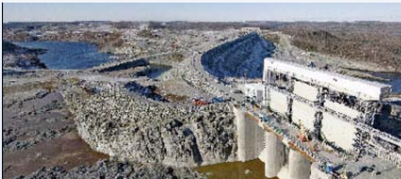
Barrage et évacuateur de crues de l'aménagement de l'Eastmain-1.
