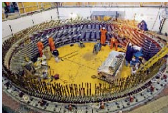
La centrale de Beauharnois fait l'objet d'importants travaux de réfection.
