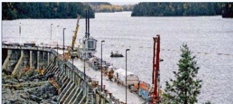
D'importants travaux de réfection se sont déroulés à la centrale des Rapides-des-Quinze.
