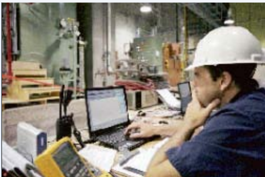
À la centrale de la Toulnostouc, prêt pour la mise en route d'un groupe turbine-alternateur.
