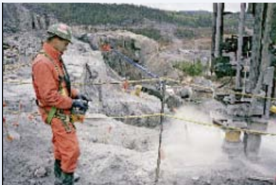
Au site de la centrale de la Péribonka, les travaux de construction vont bon train.
