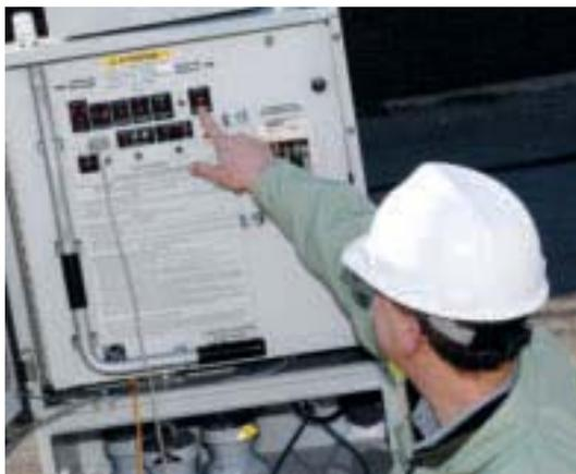
Automatisation du réseau aérien. Le coffret de commande installé à la base du poteau permet de manoeuvrer le sectionneur-interrupteur qui se trouve au-dessus, à la hauteur des lignes.
