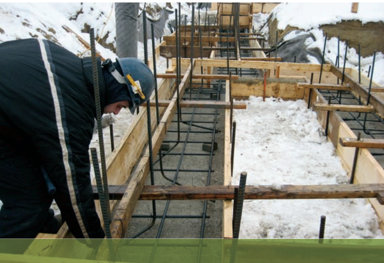
Bétonnage du bâtiment du nouveau poste de Saint-Lin, dans les Laurentides.
