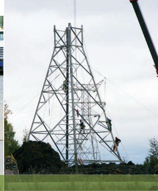
Reconstruction de la ligne Kingsey-Arthabaska, dans le Centre-du-Québec.
