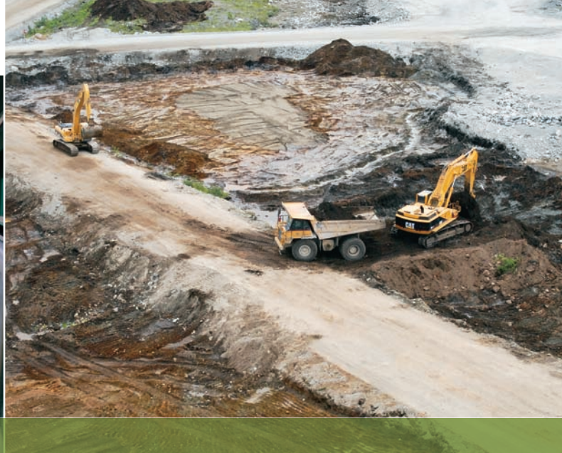
Travaux d'excavation du mort-terrain sur le site de la future centrale de l'Eastmain-1-A.
