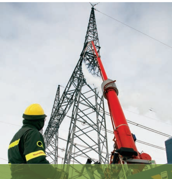
Pour déglacer des équipements, un camion muni d'une bouilloire et d'un mât télécommandé.
