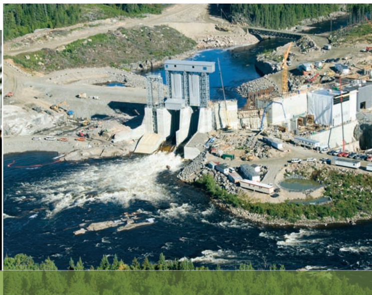
Construction de l'aménagement des Rapides-des-Cœurs, en Haute-Mauricie.
