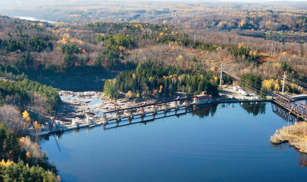
Réhabilitation du barrage Melville au complexe de Shawinigan, en Mauricie.
