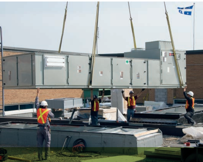
Installation d'un système de ventilation éconergétique au bâtiment administratif de la rue Jarry, à Montréal.
