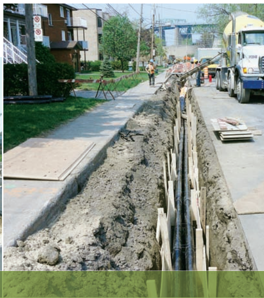
Construction de la ligne souterraine Marie-Victorin-Saint-Maxime, en Montérégie.
