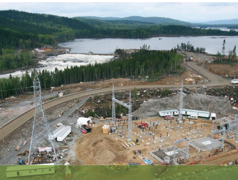
Construction du poste de la Chute-Allard, en Haute-Mauricie.
