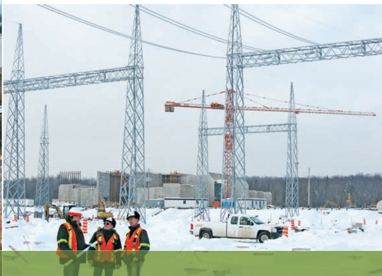
À proximité de l'Ontario, construction du poste de l'Outaouais.
