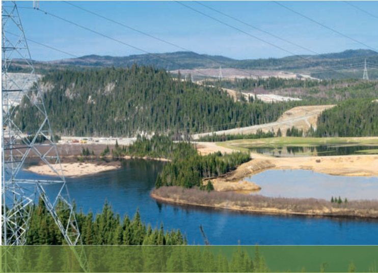
La centrale de la Péribonka est raccordée au réseau au moyen d'une ligne à 161 kV de 128 km.
