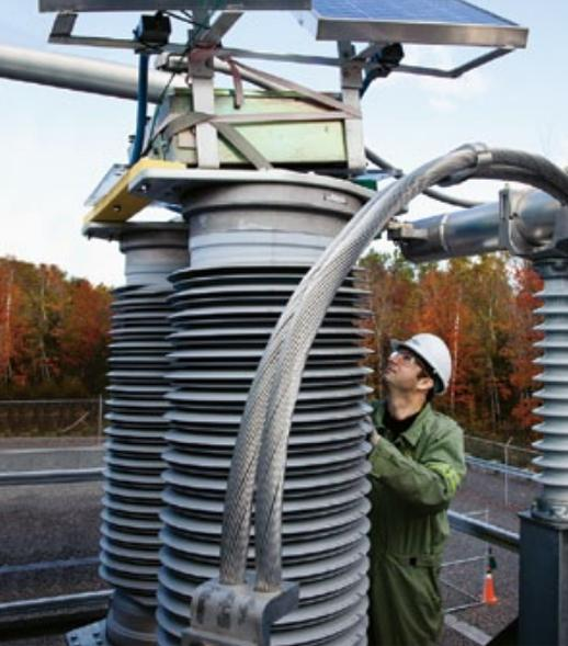
Au poste des Hêtres, à Shawinigan, le technicien Pierre Fafard inspecte le CapThor, un nouveau dispositif de protection de la batterie de condensateurs.
