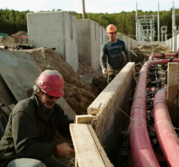
Au nouveau poste de Mont-Tremblant, dans les Laurentides, installation d'une canalisation multitubulaire pour les services auxiliaires (éclairage, système d'alarme-incendie, etc.).
