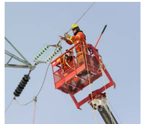
Le chef monteur Réjean Morin et le monteur Guy jr Lavoie remplacent des isolateurs sur une ligne de transport à 120 kV.
