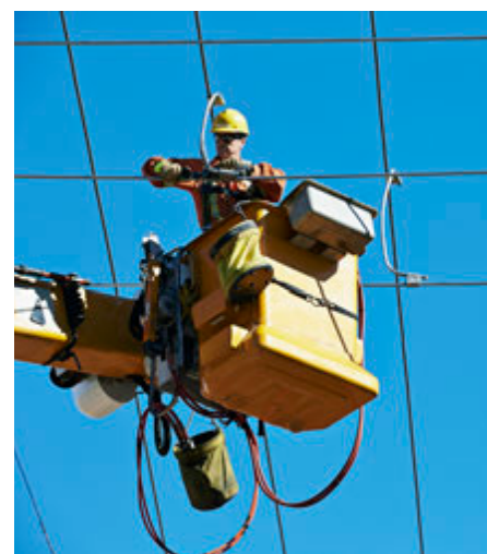
Le chef monteur Lee Millar installe une bretelle destinée à assurer la continuité électrique entre deux tronçons d'un conducteur de ligne.
