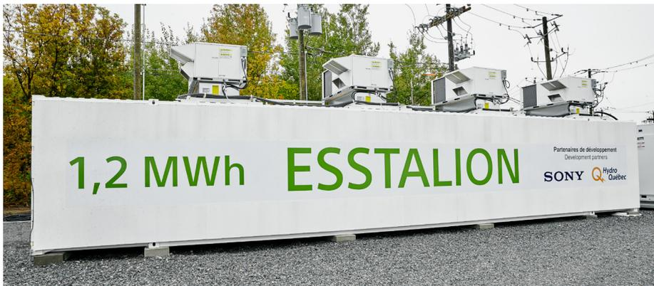
Technologies Esstalion est une coentreprise d'Hydro-Québec et de Sony (Japon) qui a mis au point un système de stockage de grande capacité capable d'accumuler 1,2 MWh d'énergie.
