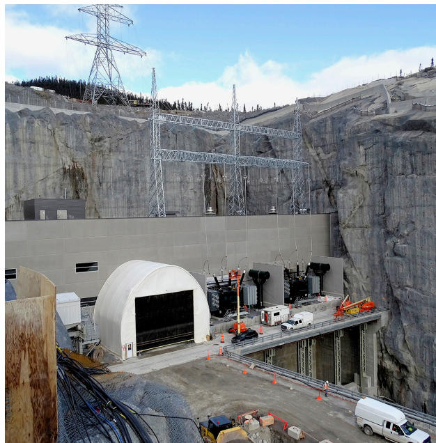
La mise en service commerciale de la centrale de la Romaine-3 est prévue pour 2017.
