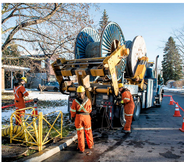
Des conducteurs à moyenne tension sont remplacés dans un quartier résidentiel.
