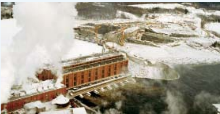
Centrale de Grand-Mère en construction.
