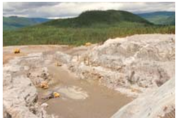
Chantier de construction de la centrale de la Toulnostouc.
