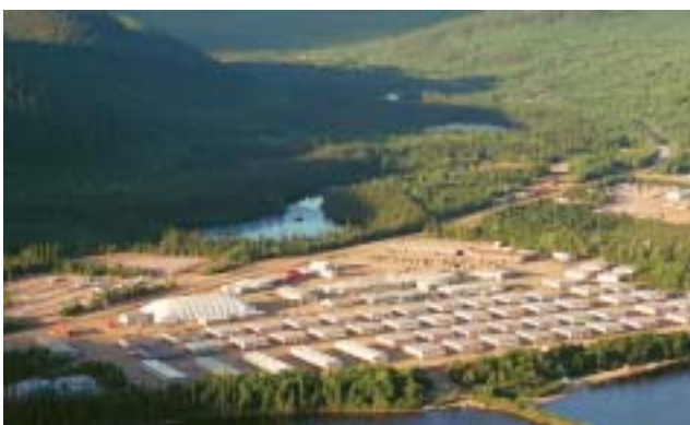
Campement du chantier de la Toulnostouc.
