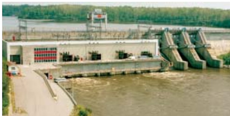
Centrale de la Première-Chute.
