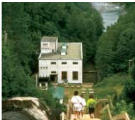
Centrale des Sept-Chutes.
