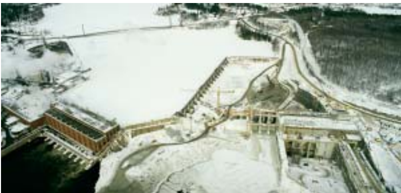
Travaux de construction de la nouvelle centrale de Grand-Mère.
