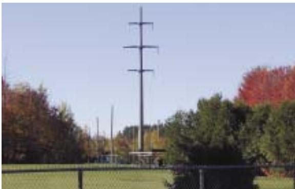
Pylônes en béton haute performance (BHP), sur la ligne à 120 kV Lafontaine-Paquin (Laurentides).
