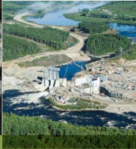
Chantier des Rapides-des-Cœurs
