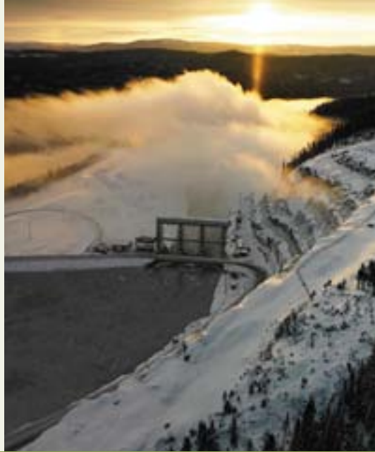
Évacuateur de crues de l'aménagement de la Péribonka
