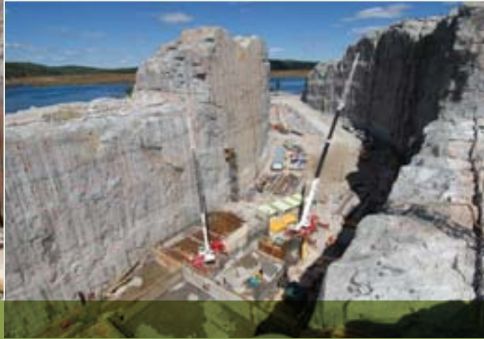
Chantier de l'Eastmain-1-A-Sarcelle-Rupert
