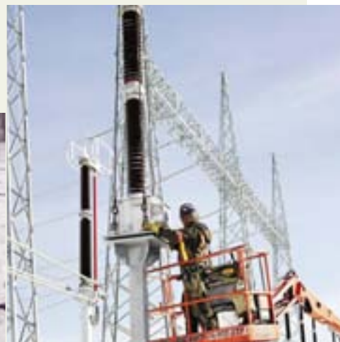
Construction du poste de l'Outaouais
