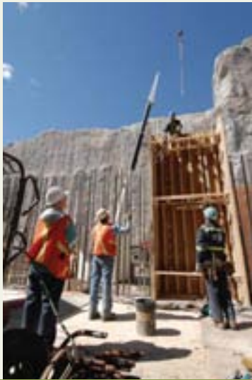
Travailleurs à l'œuvre à l'évacuateur de crues de la Rupert
