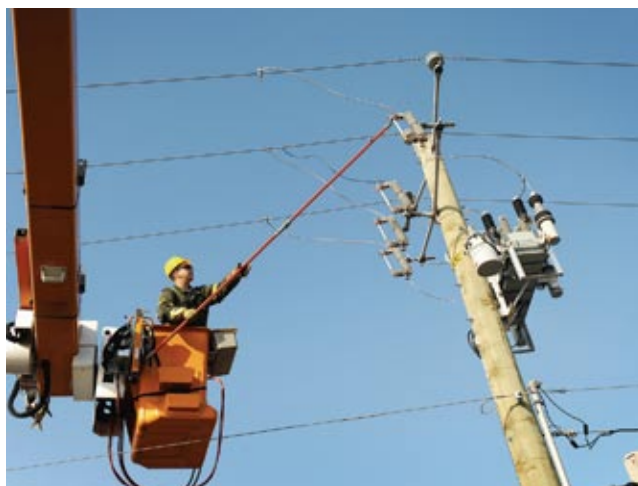
Installation d'équipements dans le cadre du projet CATVAR.
