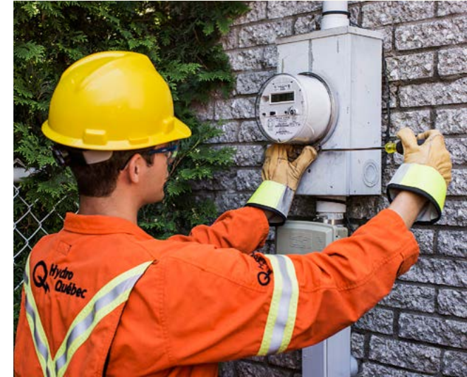
L'installateur Jean-Simon Désilets met en place un compteur de nouvelle génération.
