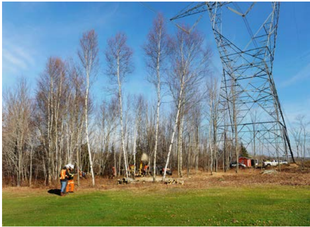
Travaux de maîtrise de la végétation dans une emprise de ligne de transport à Lévis, près de Québec. Ils sont conçus de manière à préserver la biodiversité.
