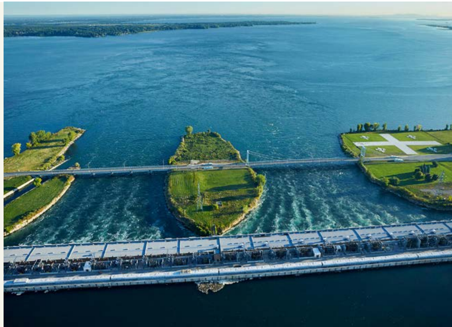
Centrale de Beauharnois, en Montérégie, une des plus grandes centrales au fil de l'eau du monde.
