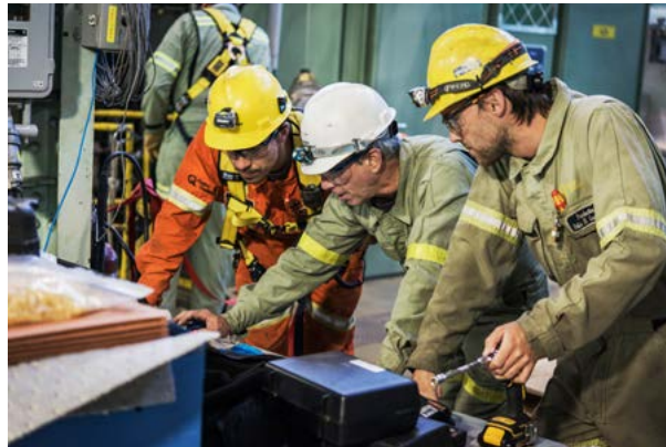
L'électricien d'appareillage Pierre-Luc Turgeon, le technicien expert Marcel Picard et l'électricien d'appareillage Félix Gaudreau discutent des tâches à effectuer dans le cadre des essais spéciaux à la centrale de Rapide-2.
