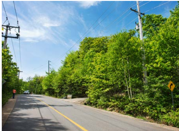
Mesure de prévention : réalisation d'un inventaire des lieux d'intervention pour les prochains travaux de maîtrise de la végétation à Sainte-Marguerite-du-Lac-Masson, dans les Laurentides.
