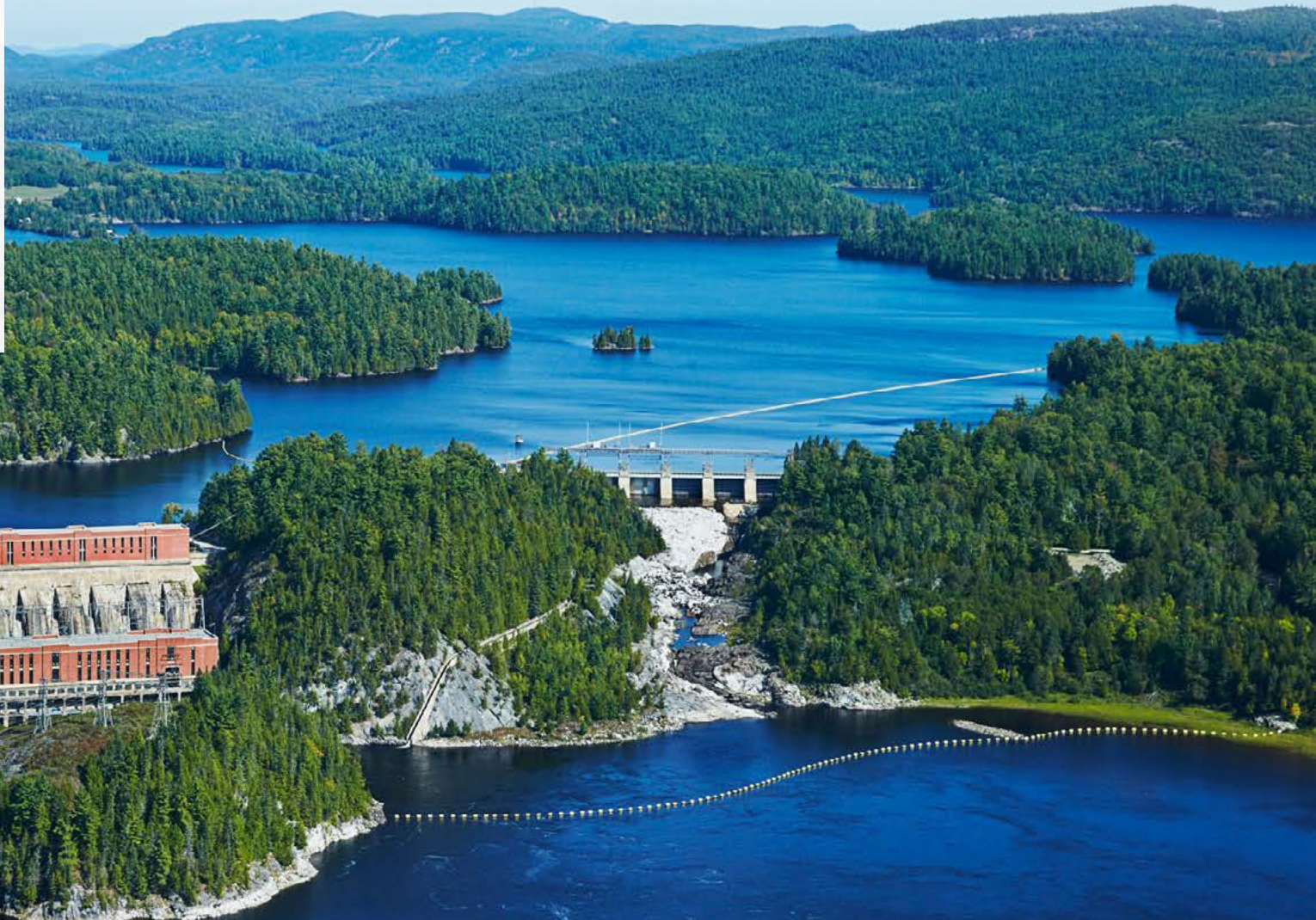
Centrale de Pagan, en Outaouais, qui a fait l'objet de travaux visant à en assurer la pérennité.
