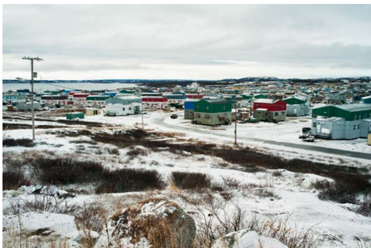
Village nordique de Kuujuaq, au Nunavik, desservi par une centrale thermique.
