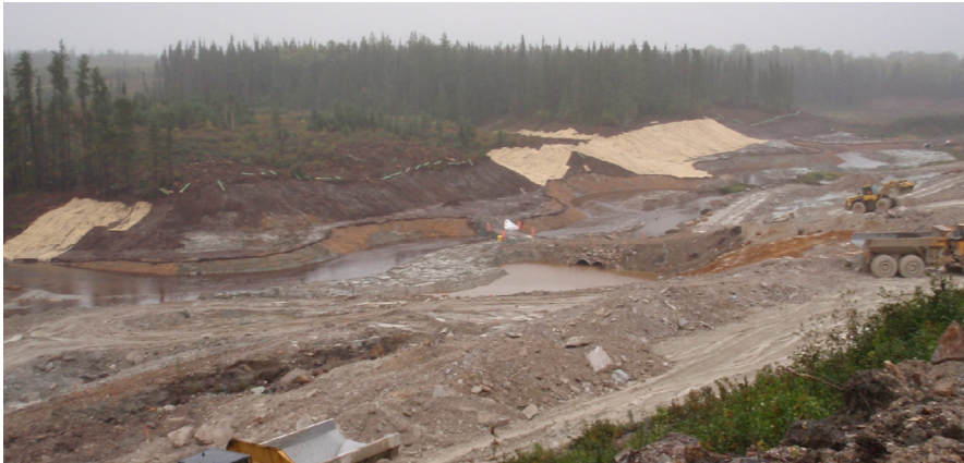
Site minier Barvue, travaux de détournement du ruisseau.
