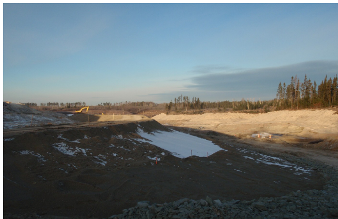
Site minier Barvue, construction de la berme.
