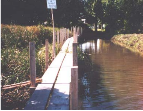
Figure 6. Vue du quai et du canal.
