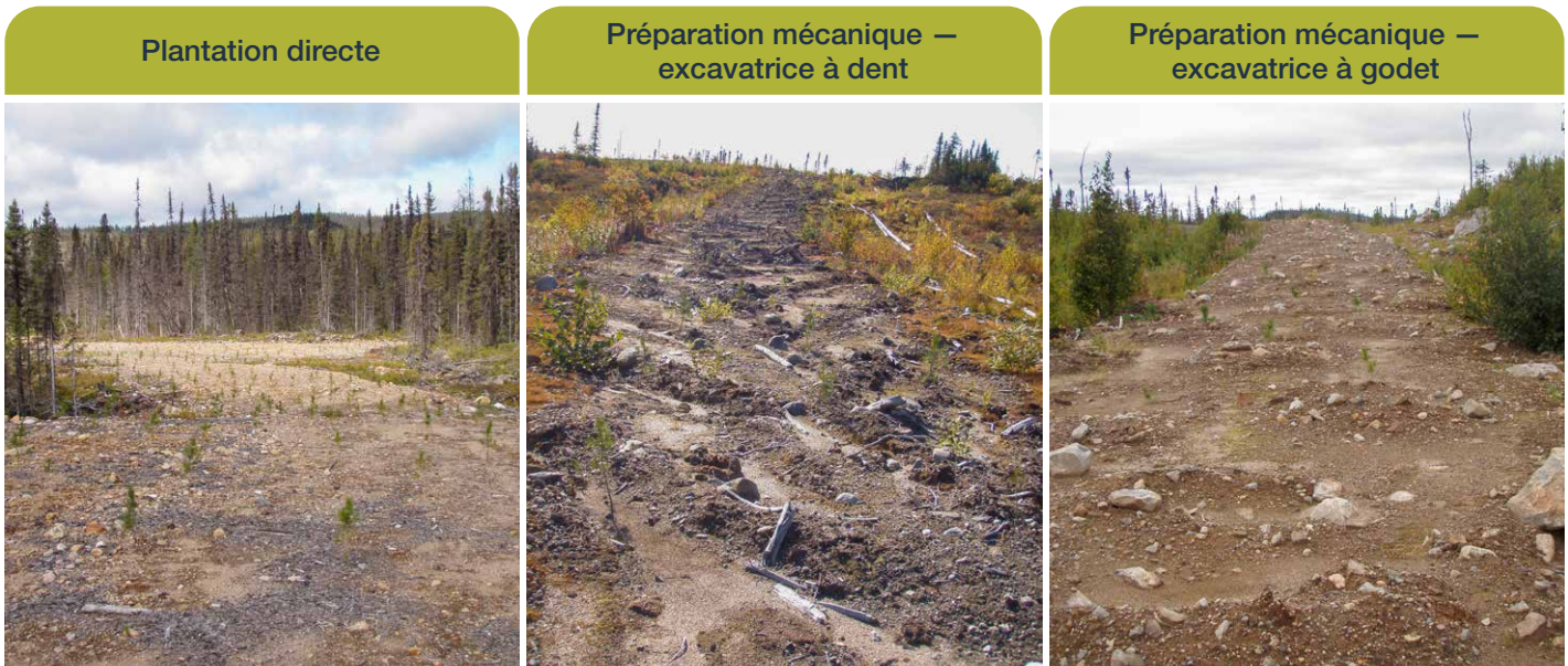
Figure 1. Aspect général des chemins forestiers deux ans après leur reboisement en pin gris en fonction de la méthode de préparation de terrain : aucune (plantation directe) ou avec préparation mécanique (excavatrice à dent ou à godet).
