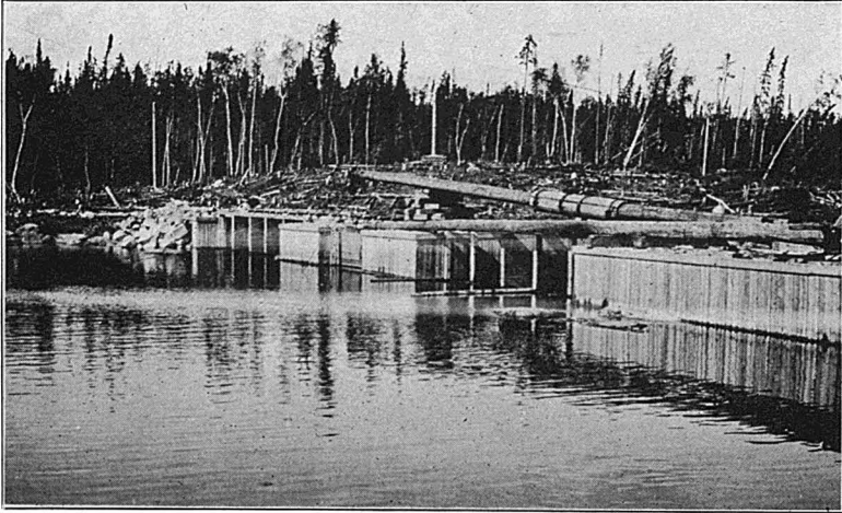
Usine Hydro-Electrique de La Loutre, barrage.
