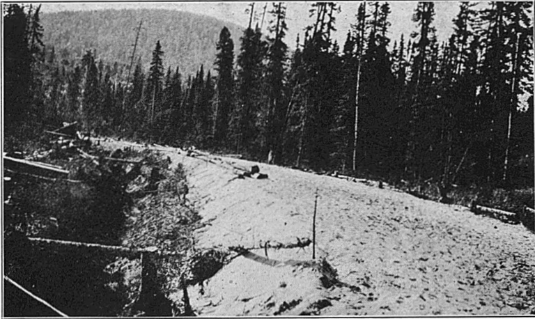
Emprise du chemin de fer entre Chaudière et La Loutre, août 1916.
