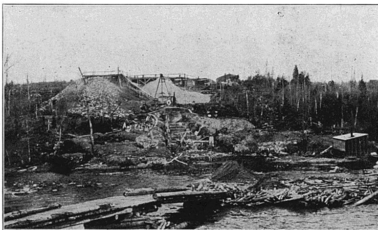
Barrage St-François, excavation nord, 9 mai 1916.
