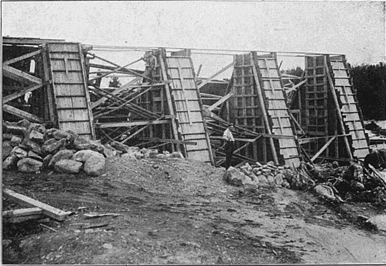
Barrage St-François, vue arrière des formes 24, 25, 26, 27, 23 juin 1916.
