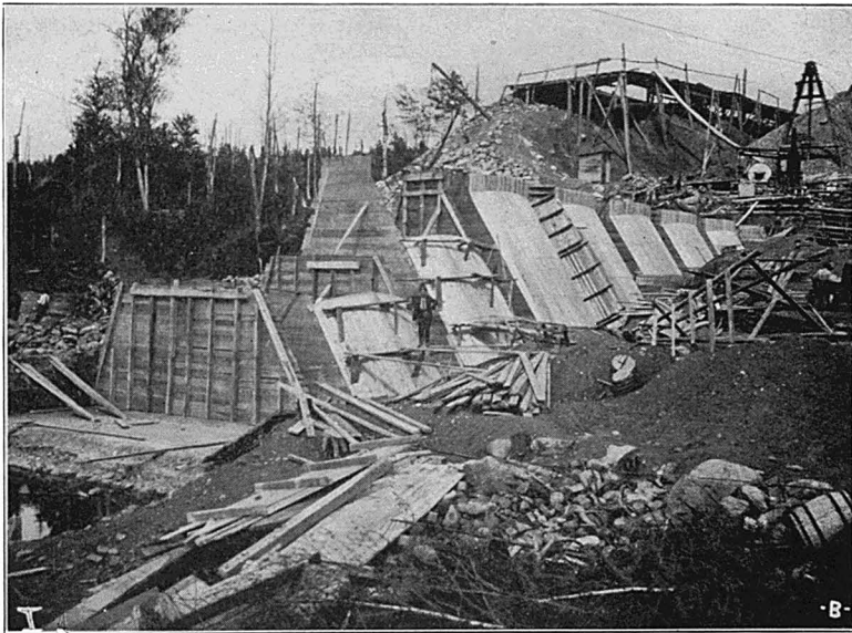
Barrage Saint-François, vue des formes pour la partie du barrage située dans le canton Coleraine, juin 1916.
