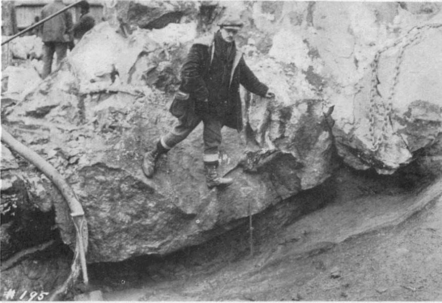
BARRAGE RÉSERVOIR LA LOUTRE.—Vue montrant une fissure remplie de sable séparant le roc solide du roc mobile.
