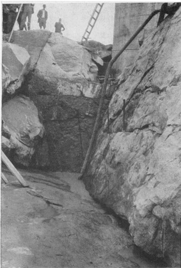
BARRAGE RÉSERVOIR LA LOUTRE.—Tranchée profonde pour mur écran à l'amont du barrage entre les chaînages Ouest 0+24 et Ouest 0+48.
