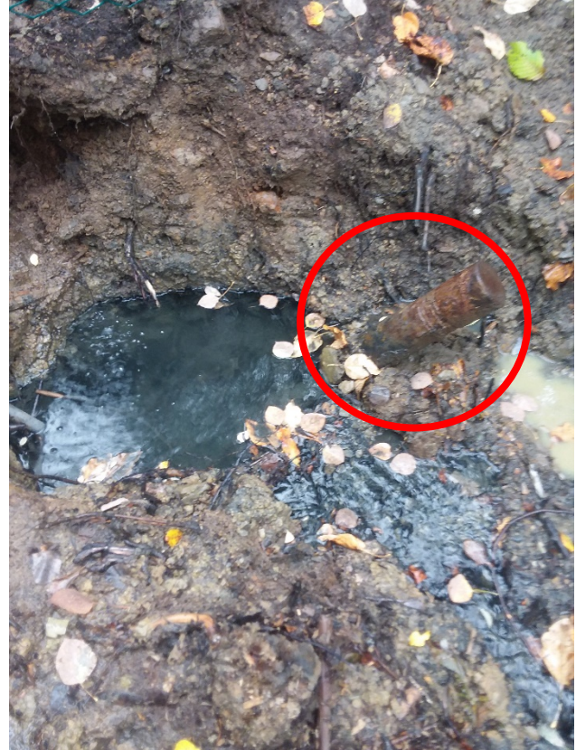
Figure 4 : Vue du tubage incliné à 50°, le 7 octobre 2020.
