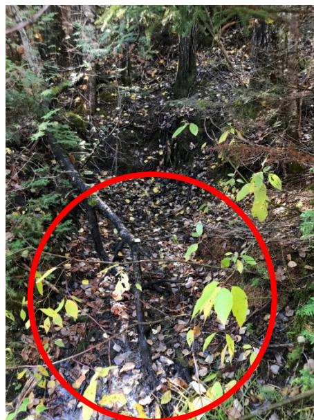
Figure 2 : Excavation présentant un écoulement d'eau sulfurée accompagnée de pétrole à proximité du puits CS34 au 8 octobre 2019.
