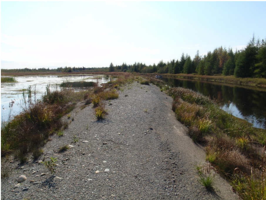
Photo 10 : Digue aménagée sur la rive droite de la station 5
