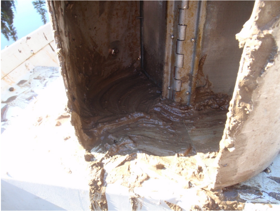
Photo 1 : Sédiments de la station 2-A
