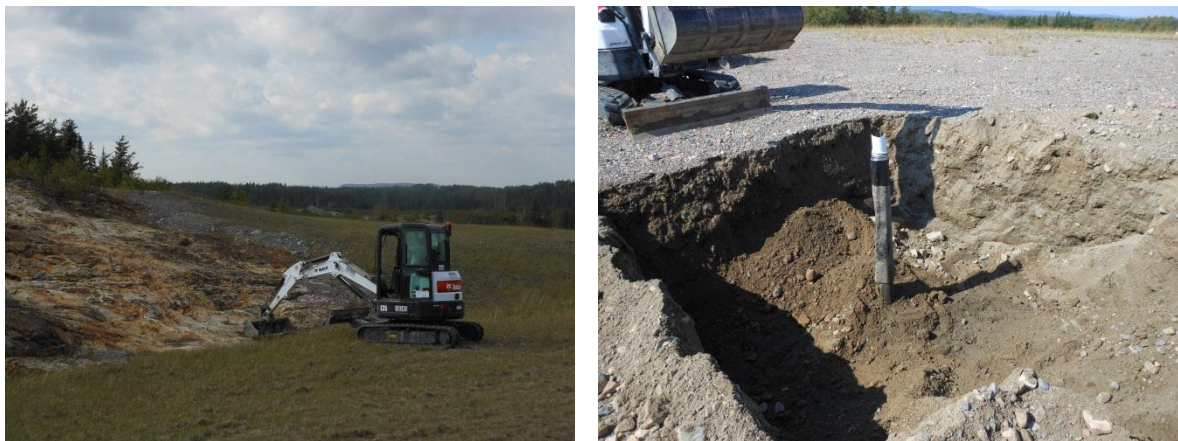
Figure 37 : Photos des travaux d'excavation
