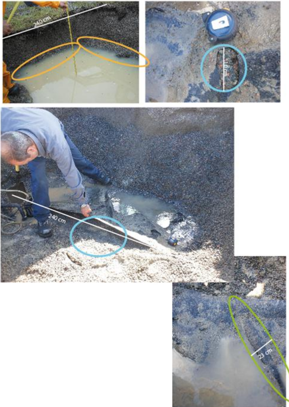
Figure 41 : Excavation sur la jointure avec le cap de roche
