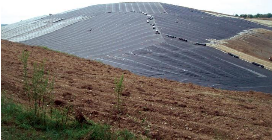
Figure 9 : Butte avec GM installée (source : geosyntheticsmagazine.com)
