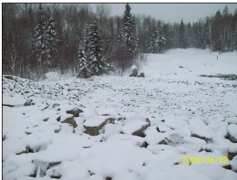
Photo 7.10 : Déversoir Nord – Enrochement aval
