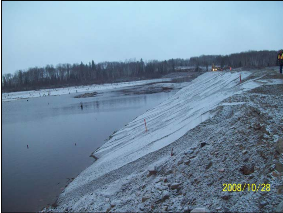
Photo 5.21 : Digue G – Sable 2A d'assise pour géomembrane
