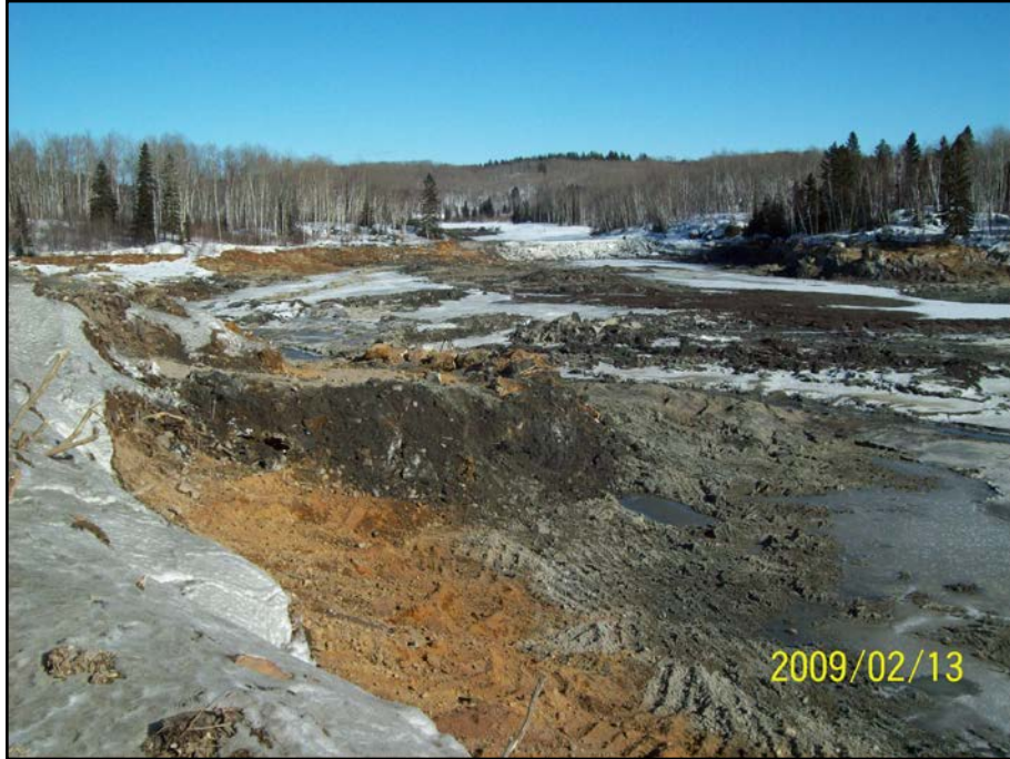
Photo 6.11 : Secteur Intermédiaire – Surface nettoyée vue ouest
