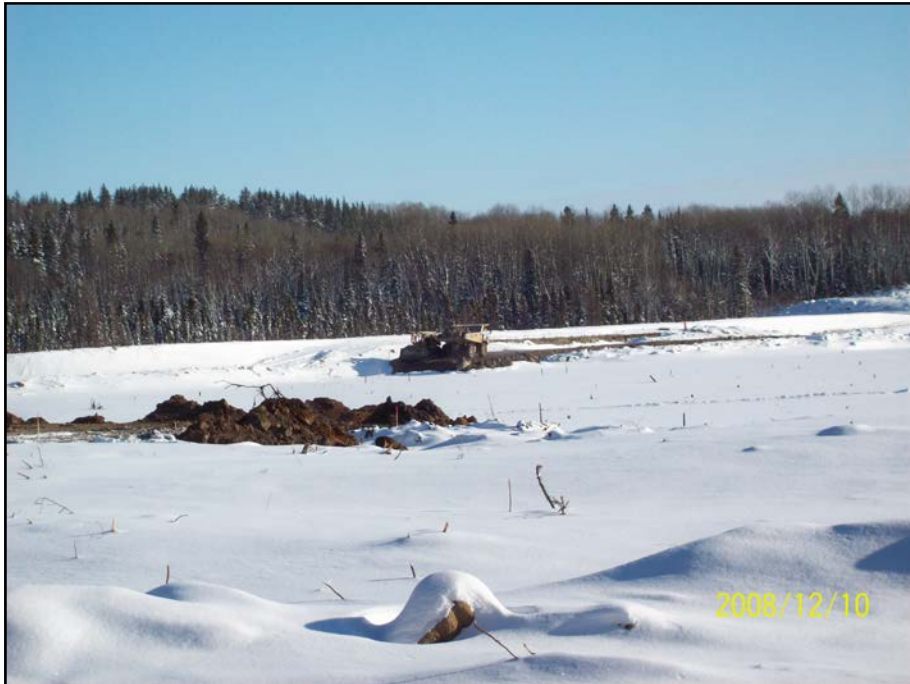
Photo 8.6 : Terrasse 2 – Épandage de résidus
