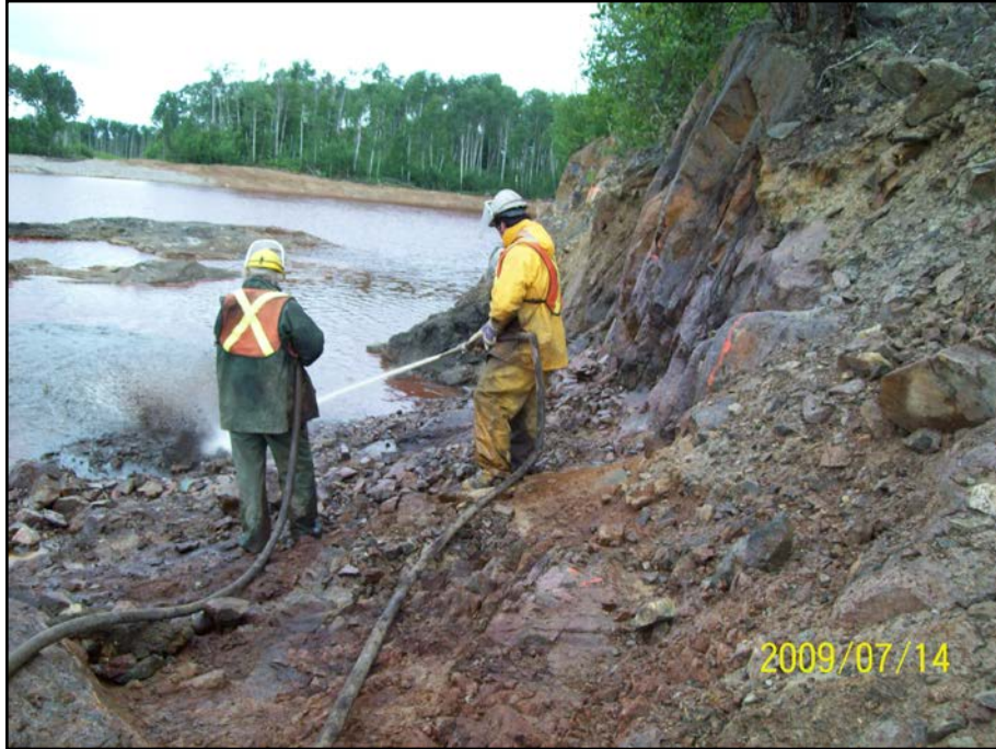
Photo 6.25 : Secteur Intermédiaire – Lavage de roc côté est
