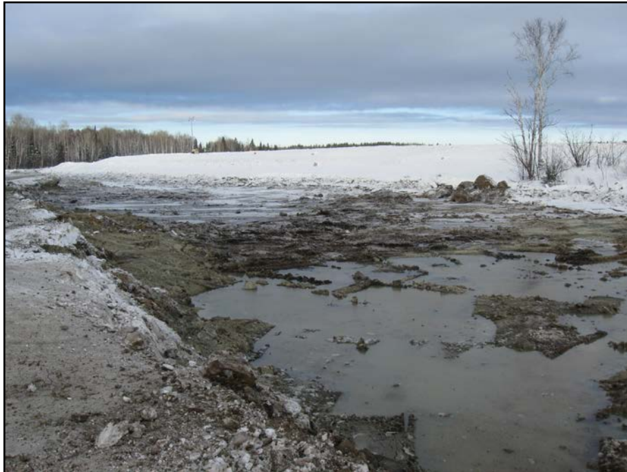
Photo 6.20 : Secteur Nord – Excavation des résidus à l'aval de la digue F
