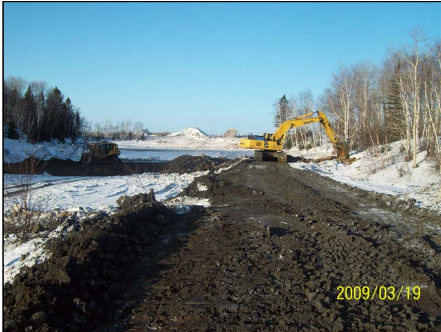
Photo 8.2 : Terrasse 1 – Épandage des résidus
