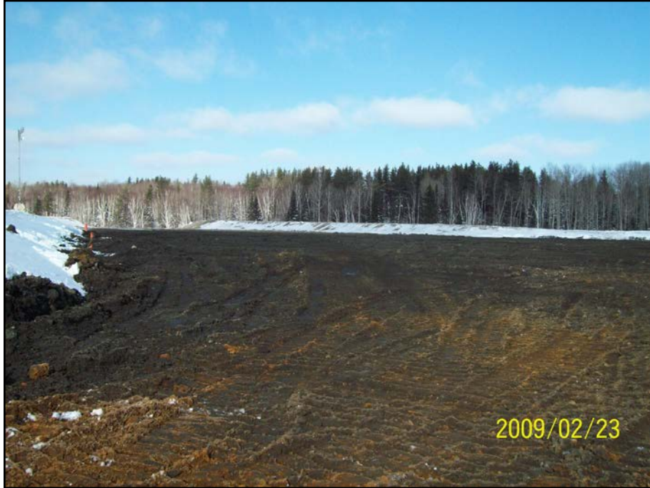
Photo 8.5 : Terrasse 2 – Résidus en place
