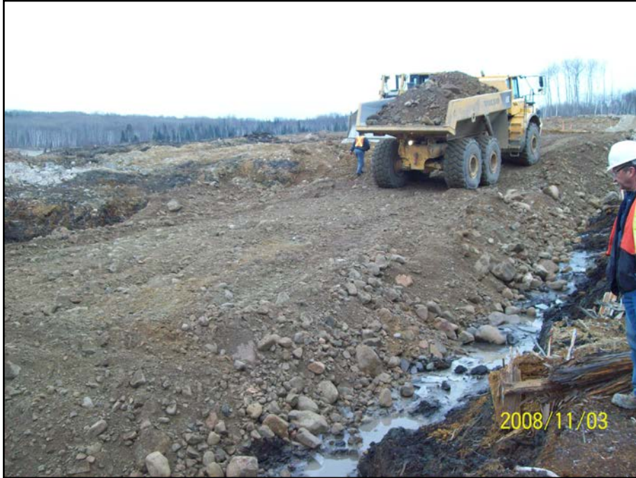
Photo 5.11 : Digue F – Remblai granulaire zone 2
