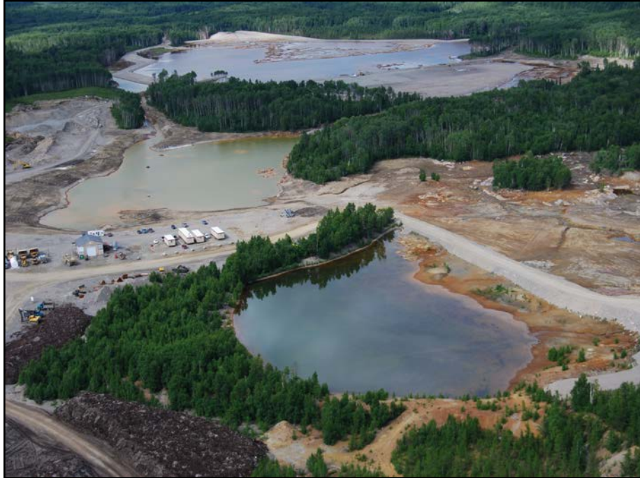
Photo 14.9 : Bassin aval de la digue C
