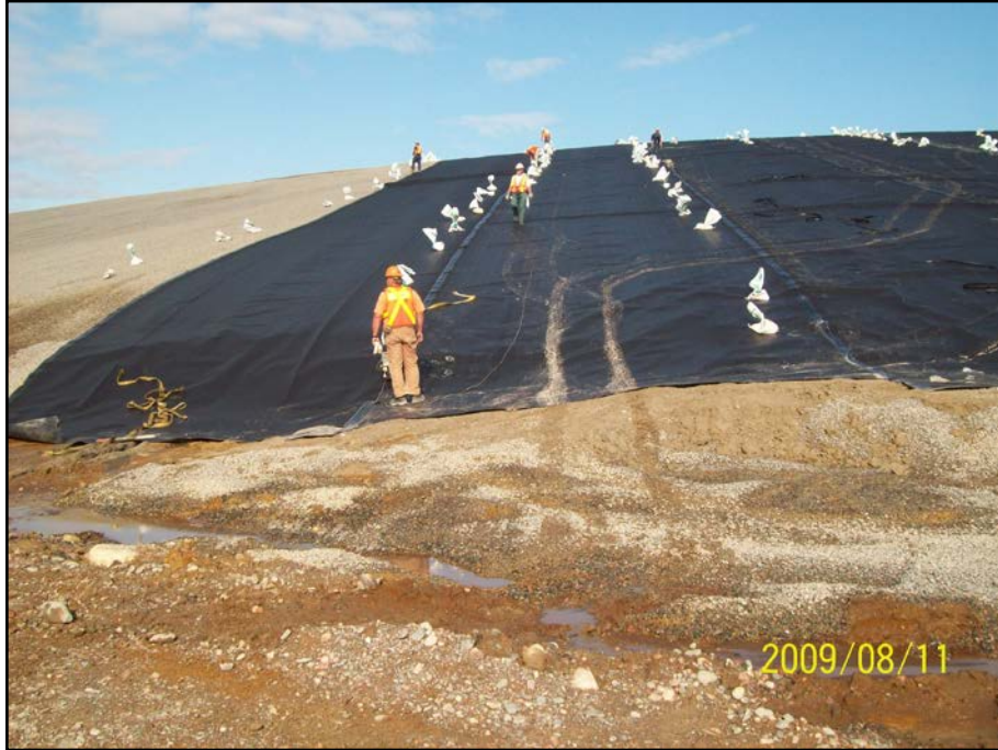
Photo 9.7 : Installation de géomembrane de la cellule
