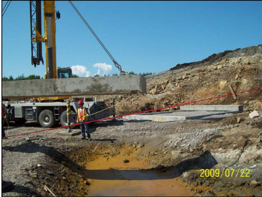
Photo 14.3 : Mise en place des dalles de béton
