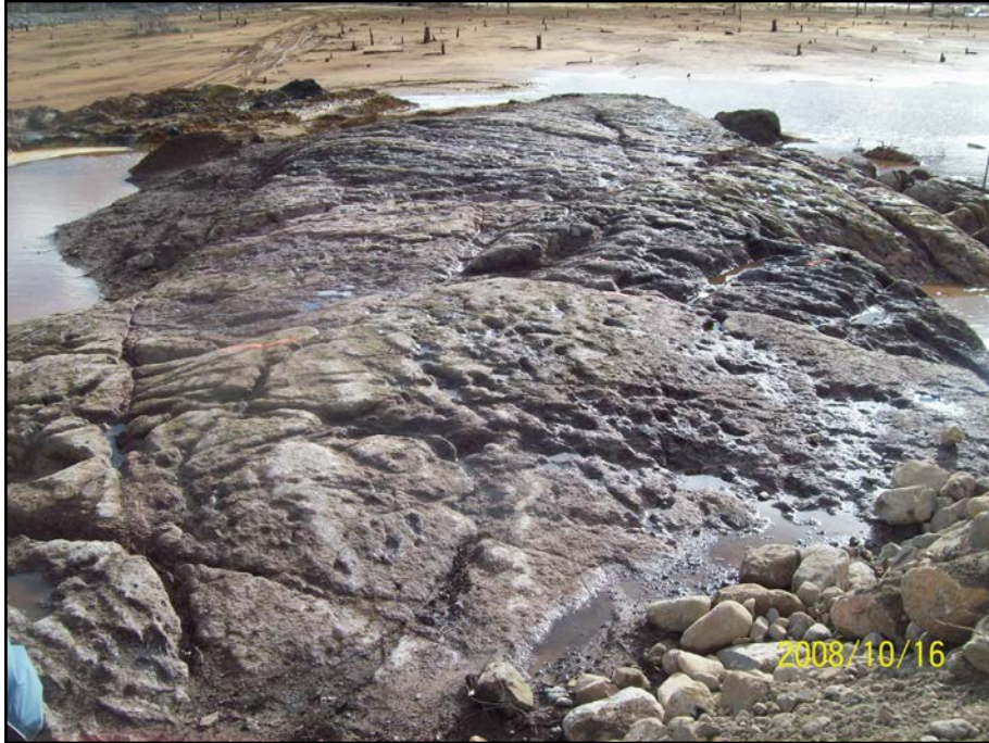
Photo 5.17 : Digue G – Fondation sur roc
