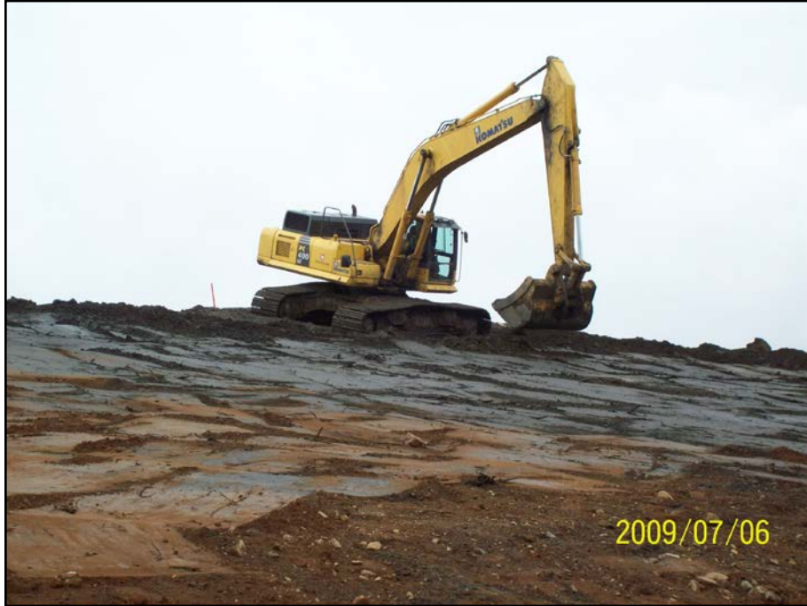
Photo 9.3 : Cellule de confinement – Profilage des résidus
