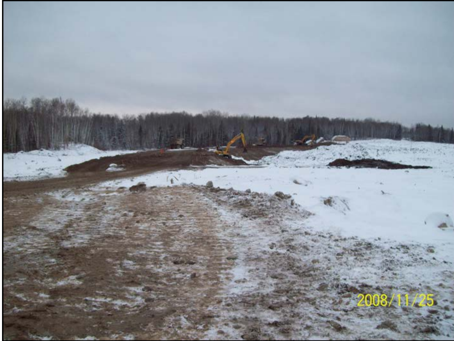
Photo 5.13 : Digue F – Remblayage côté aval
