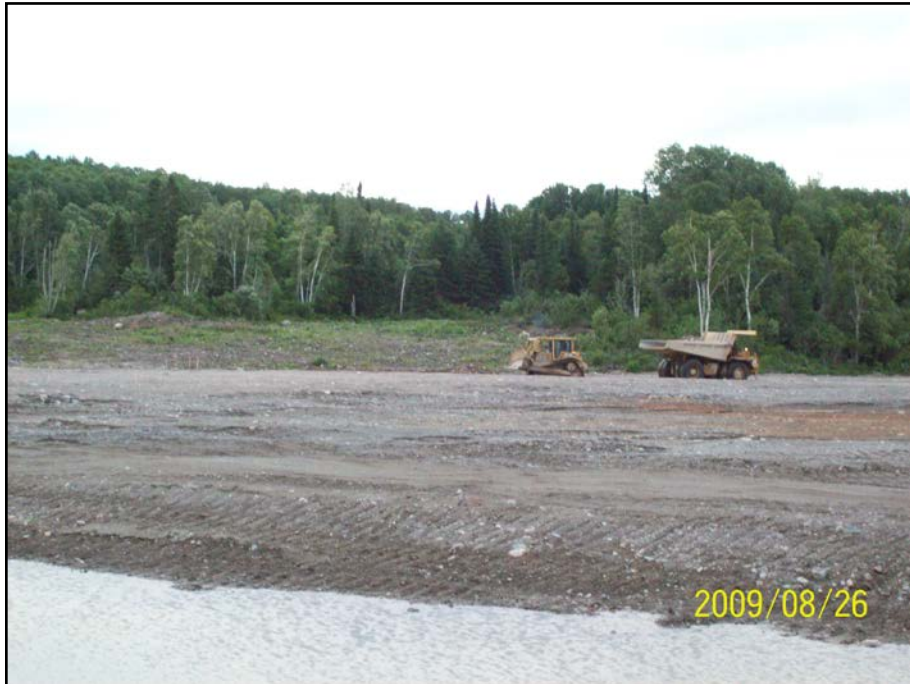
Photo 8.10 : Terrasse 1 – Rehaussement de la terrasse
