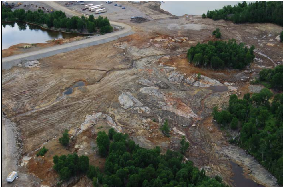
Photo 12.4 : Secteur Sud – Surfaces terminées et nivelées
