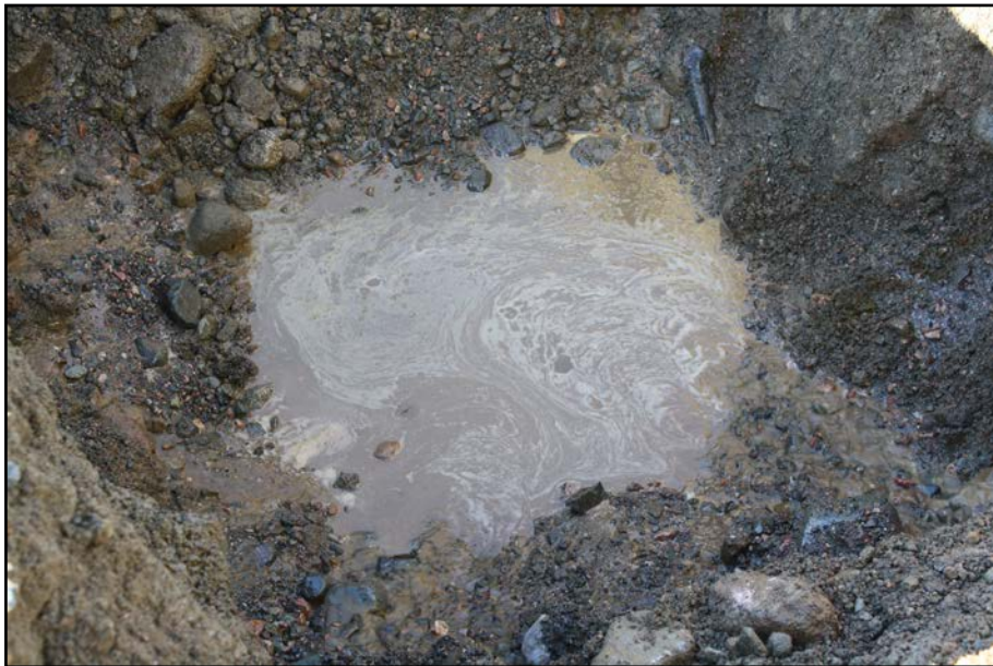
Photo 14.4 : Excavation pour puits d'observation
