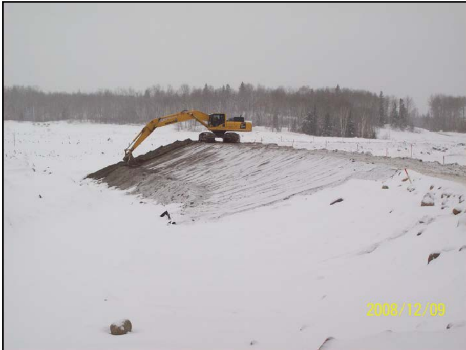
Photo 5.14 : Digue F – Mise en place du sable 2A d'assise pour la géomembrane
