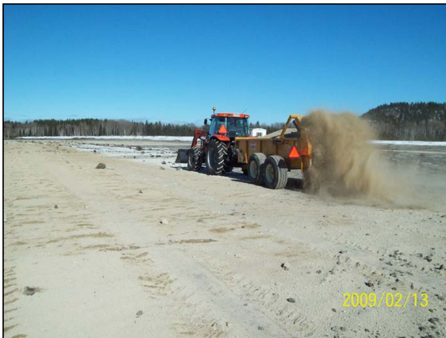
Photo 8.7 : Terrasse 2 – Épandage de chaux
