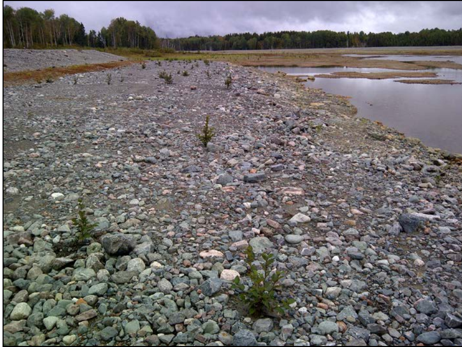
Photo 8.11 : Terrasse 2 – Nouvelle berme au pied du talus amont de la digue F (travaux 2011)
