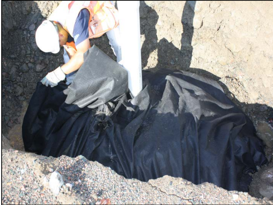
Photo 14.7 : Puits d'observation – enrobage du filtre
