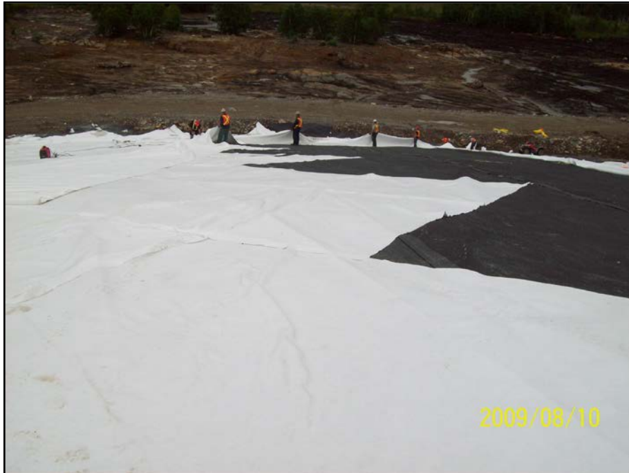
Photo 9.6 : Géotextile de protection de la géomembrane
