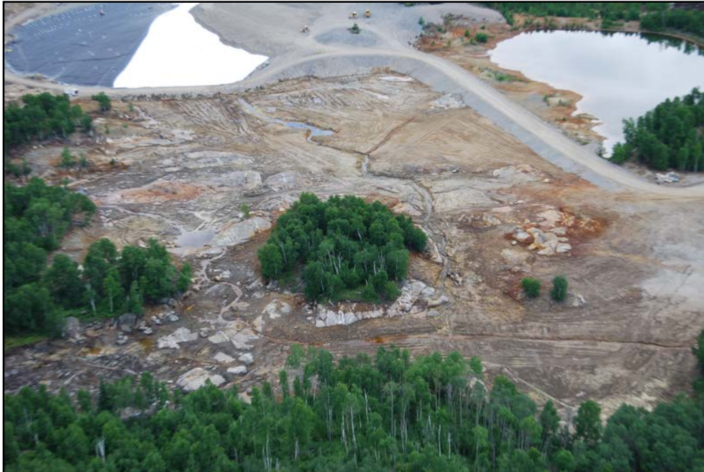
Photo 6.18 : Secteur Sud – Surface nettoyée vue aérienne
