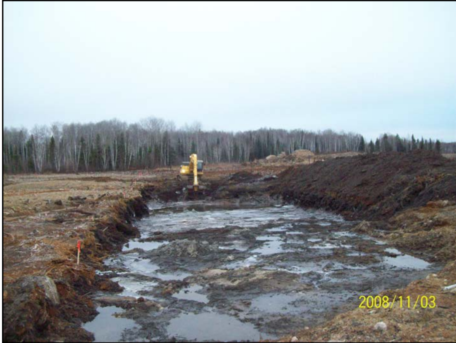
Photo 6.19 : Secteur Nord – Excavation des résidus à l'amont de la digue F
