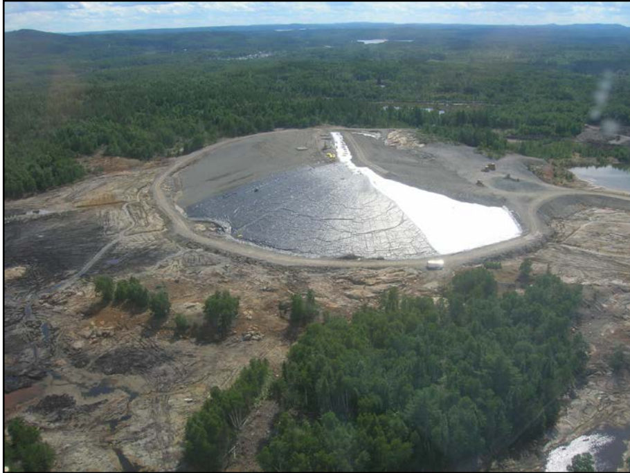
Photo 9.9 : Cellule de confinement – Vue générale
