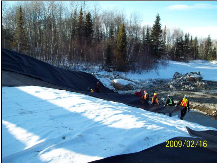
Photo 7.8 : Déversoir Nord – Installation géomembrane sur le talus aval
