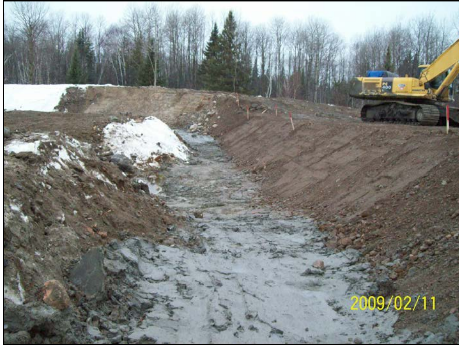
Photo 7.7 : Déversoir Nord – Clé en argile pour ancrage de la géomembrane
