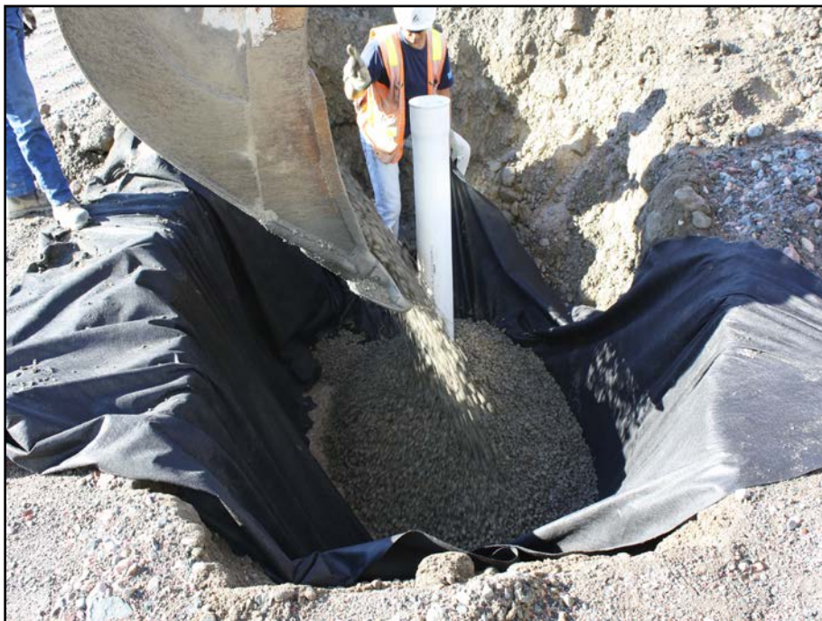
Photo 14.6 : Puits d'observation – Mise en place du filtre
