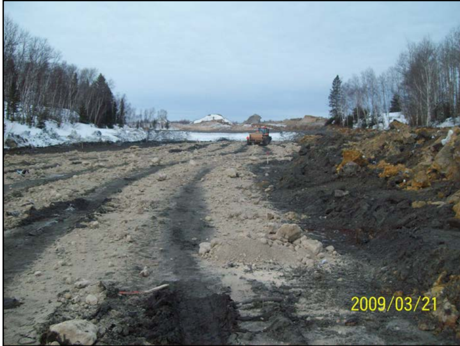
Photo 8.3 : Terrasse 1 – Épandage de chaux
