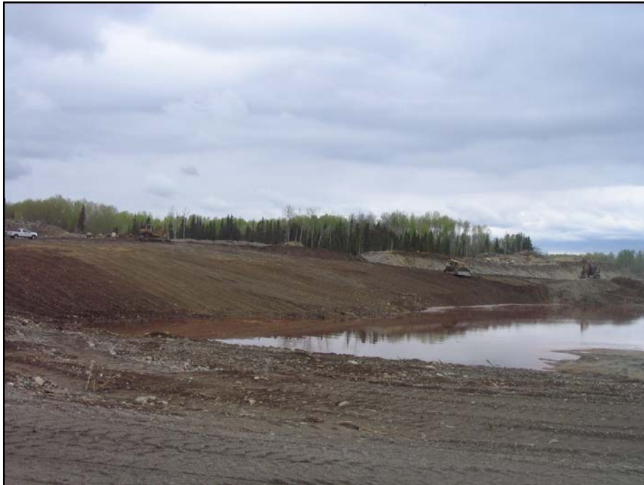
Photo 12.2 : Secteur Intermédiaire – Adéquation et réglage des talus
