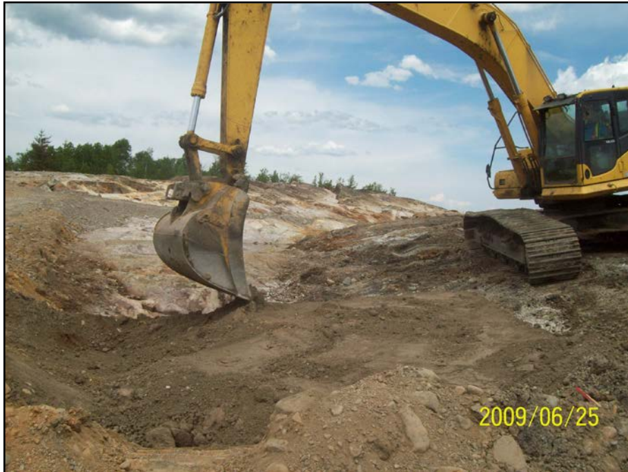
Photo 9.2 : Mise en place d'argile pour ancrage de la géomembrane
