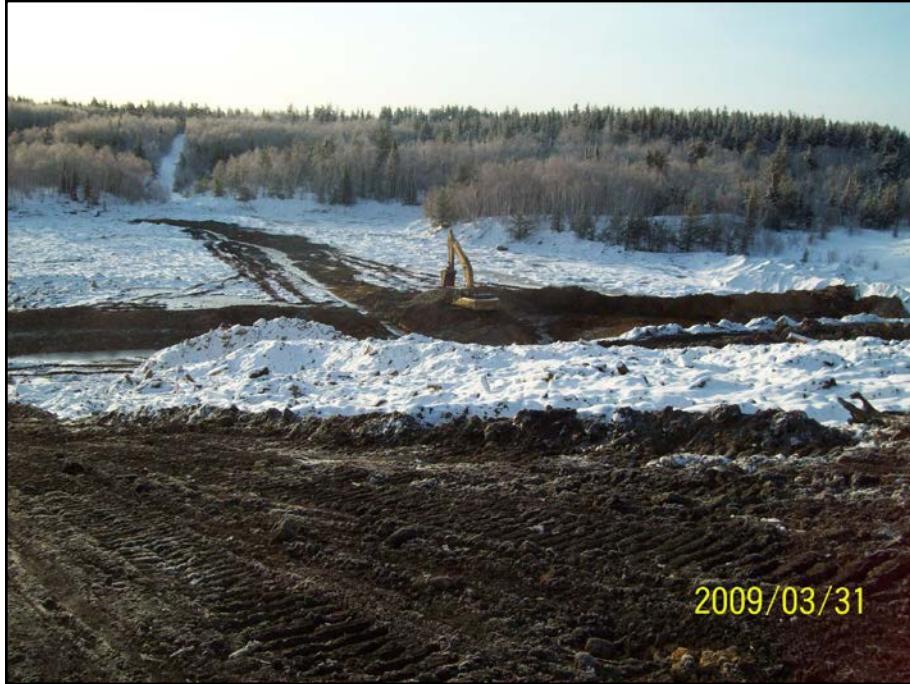
Photo 6.17 : Secteur Sud – Excavation des résidus
