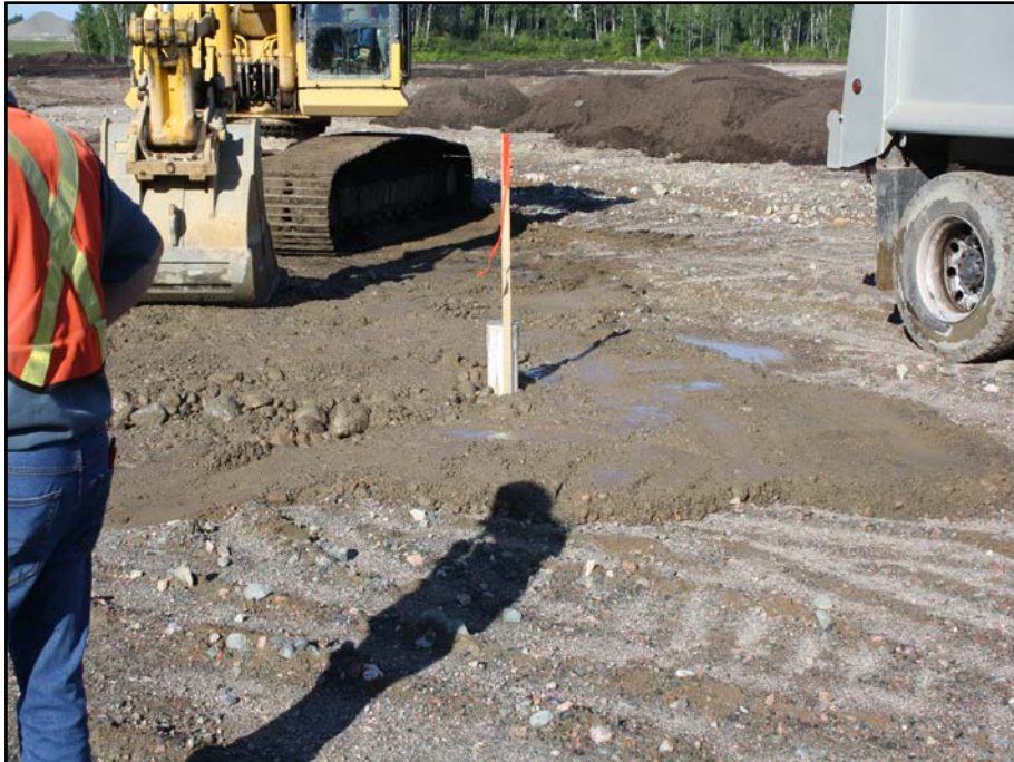
Photo 14.8 : Puits d'observation terminé
