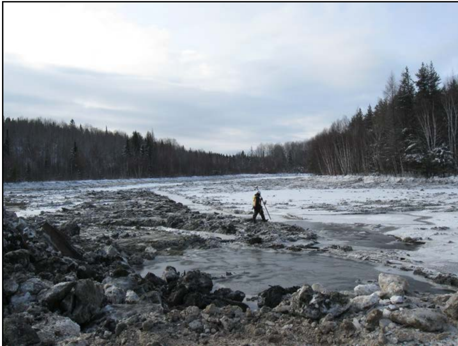
Photo 6.4 : Ruisseau 1 – Surface nettoyée à l'amont du seuil
