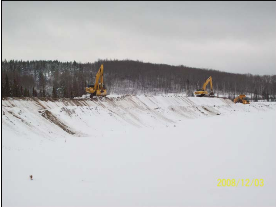
Photo 5.9 : Digue E est – Remblayage de la crête
