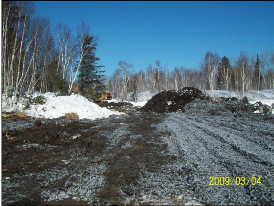
Photo 6.15 : Secteur Sud – Excavation des résidus côté est
