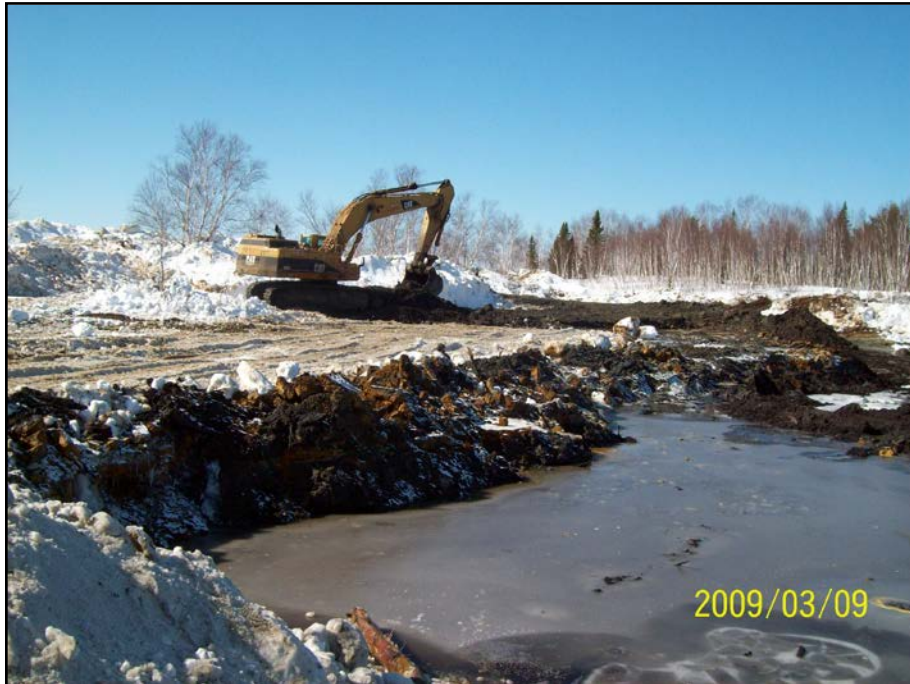
Photo 6.16 : Secteur sud – Excavation des résidus zone sud-ouest
