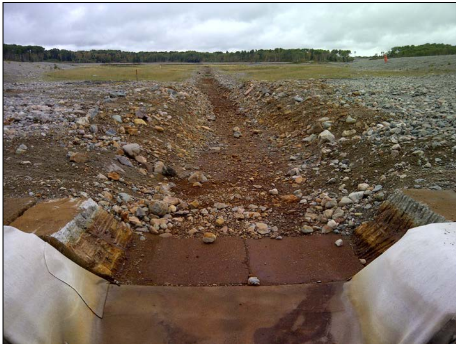
Photo 8.12 : Déversoir Nord – Seuil du déversoir abaissé de 50 cm et fossé de drainage adapté (travaux 2011)
