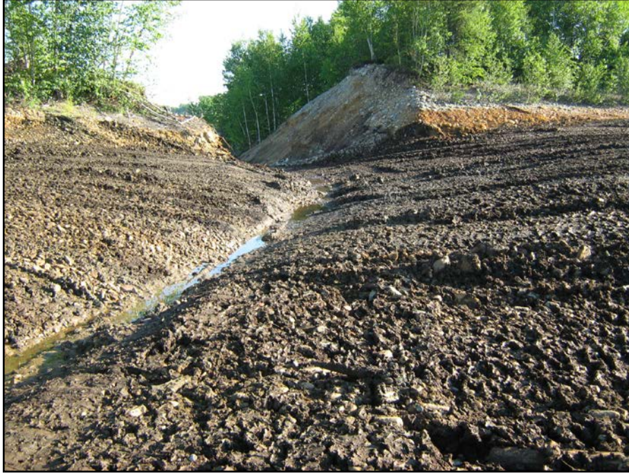
Photo 14.13 : Bassin digue C – Fossé de drainage permanent
