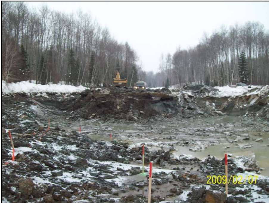
Photo 7.12 : Ruisseau 1 – Excavation bassin de décantation
