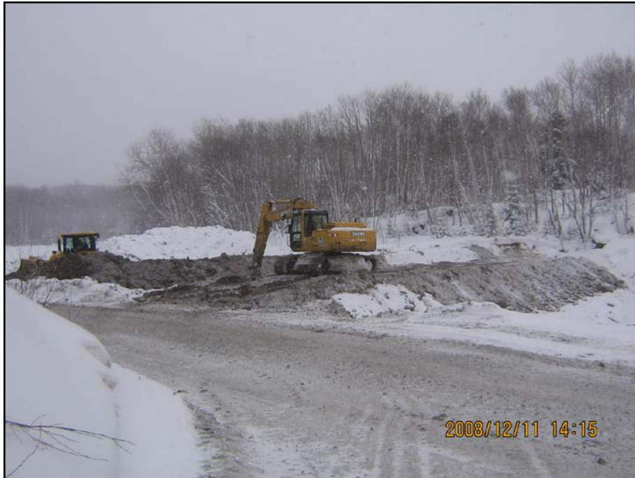
Photo 5.24 : Digue H – Noyau en argile
