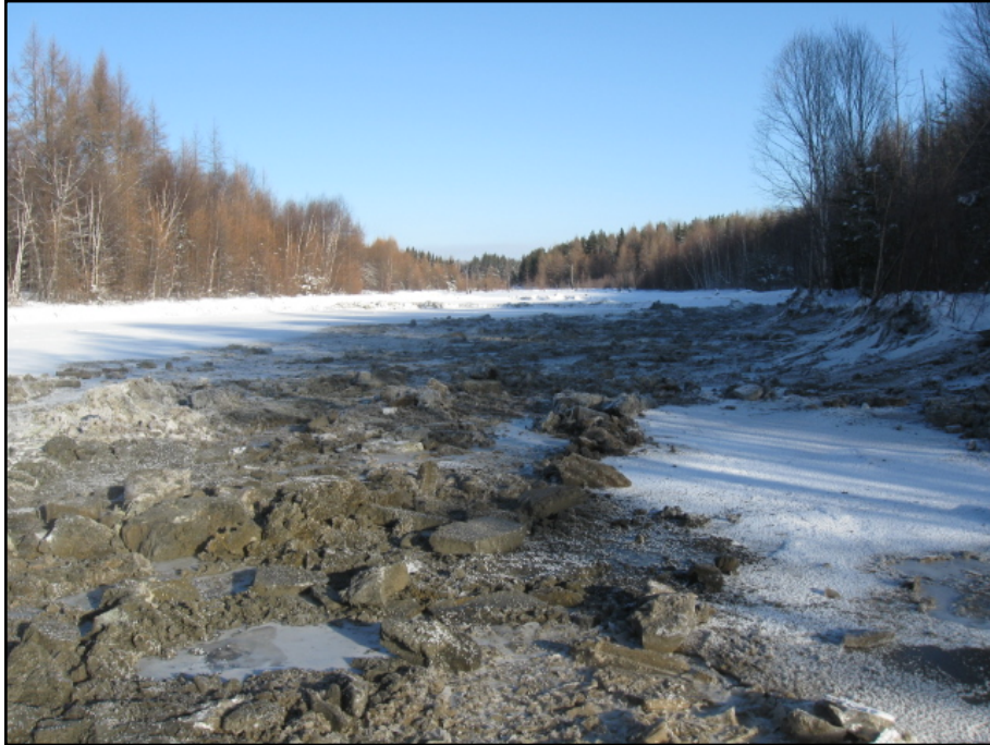
Photo 6.3 : Ruisseau 1 – Surface nettoyée à l'aval du seuil
