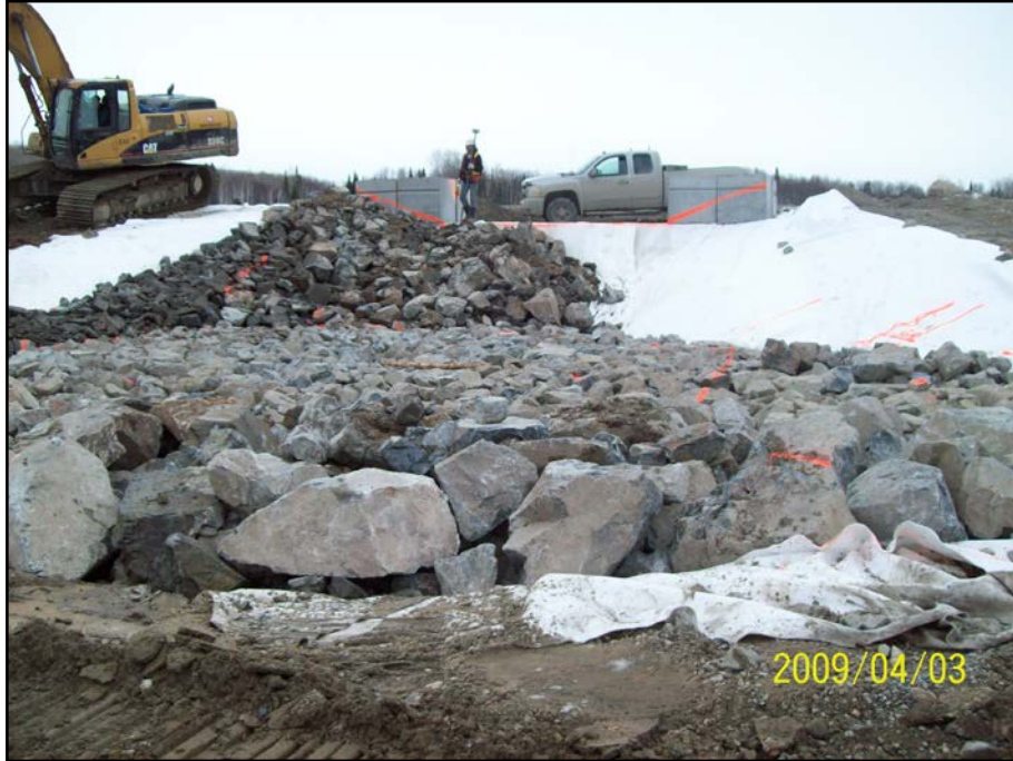
Photo 7.5 : Digue G – Enrochement aval des déversoirs
