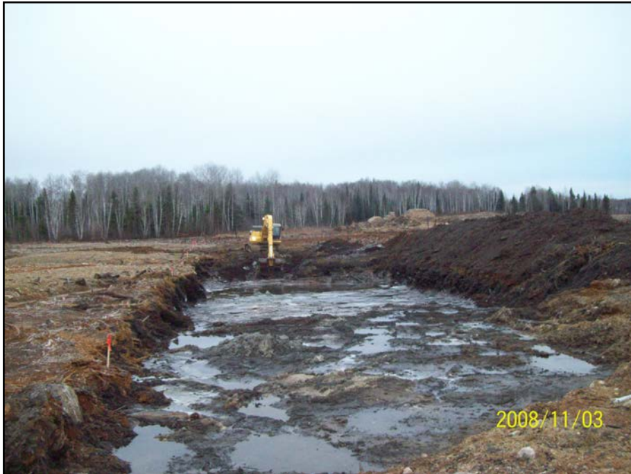
Photo 5.10 : Digue F – Fondation sur argile
