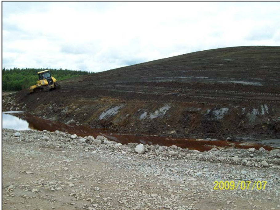
Photo 9.4 : Cellule de confinement – Profilage des résidus
