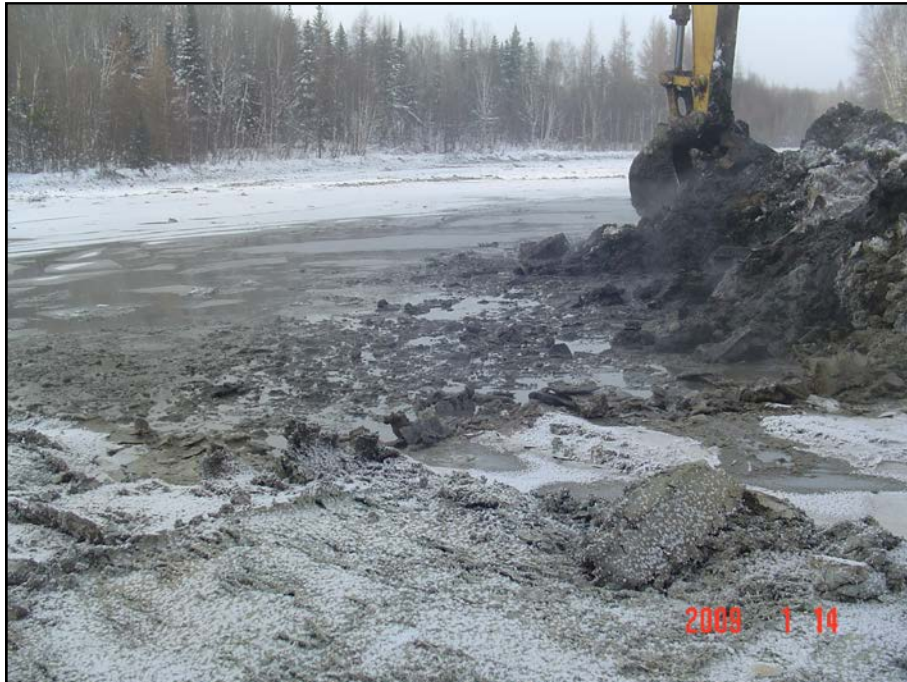
Photo 6.2 : Ruisseau 1 – Excavation des résidus
