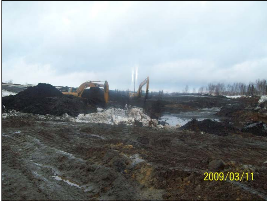
Photo 6.13 : Secteur Sud – Excavation des résidus zone centrale
