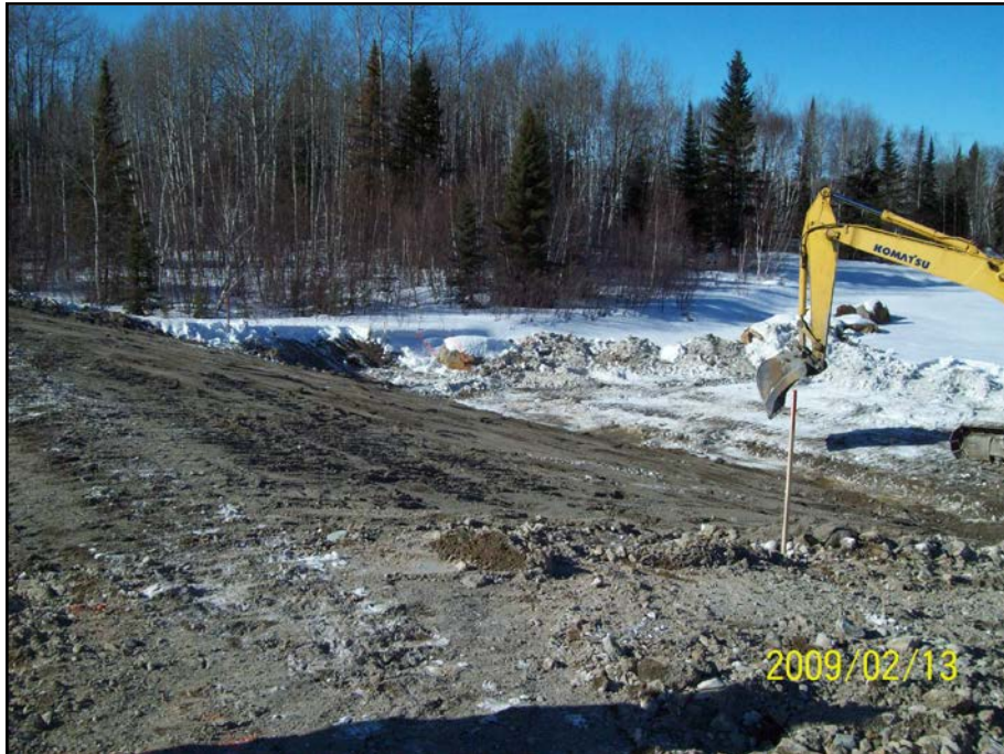
Photo 7.6 : Déversoir Nord – Talus aval
