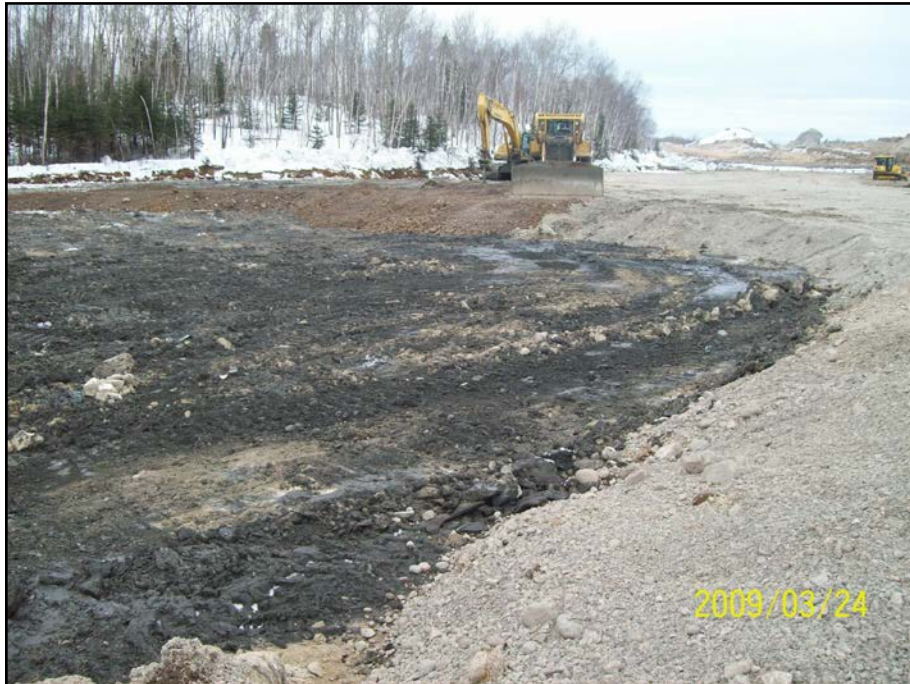
Photo 8.4 : Terrasse 1 – Mise en place de la monocouche
