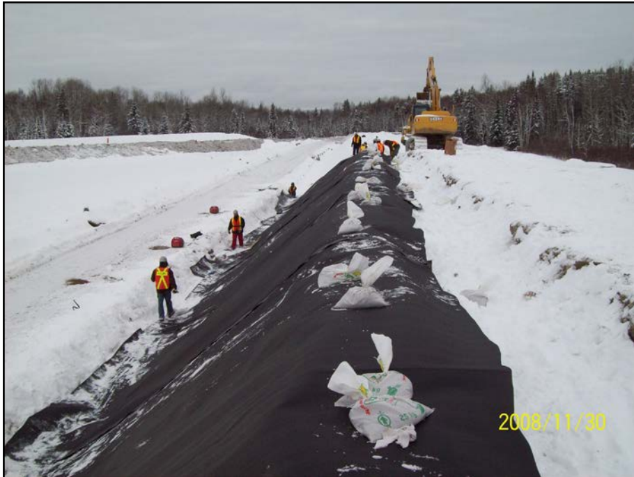
Photo 5.8 : Digue E est – Installation géomembrane
