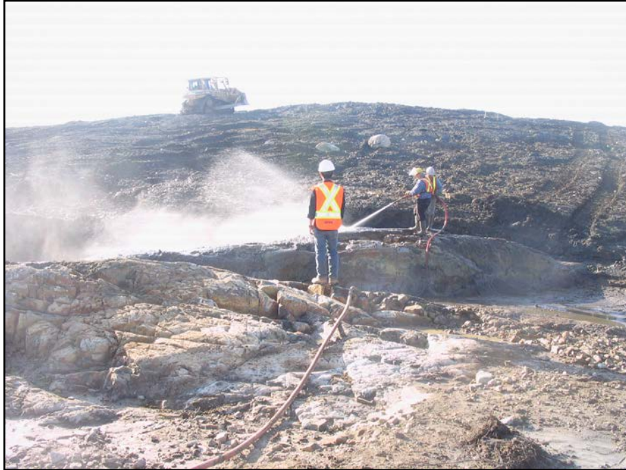
Photo 6.23 : Secteur Sud – Lavage du roc
