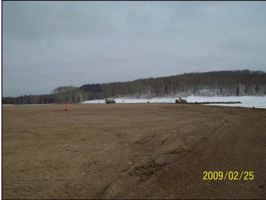
Photo 8.9 : Terrasse 2 – Monocouche en place
