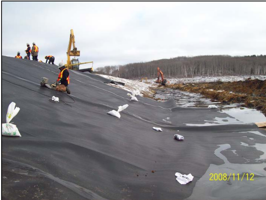
Photo 5.22 : Digue G – Installation de la géomembrane
