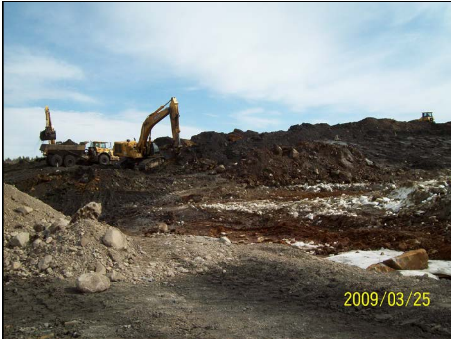
Photo 6.14 : Secteur Sud – Excavation des résidus zone du puits d'accès
