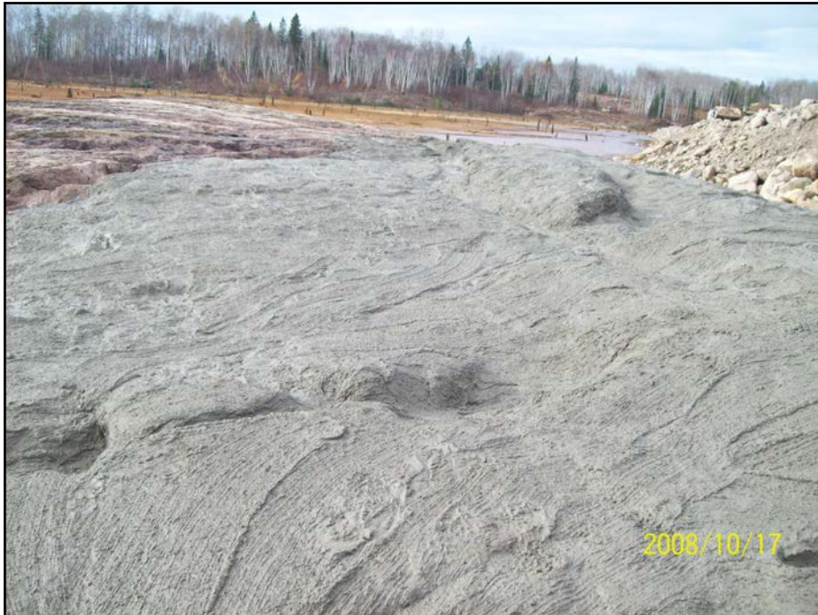
Photo 5.18 : Digue G – Coulis de béton sur fondation rocheuse
