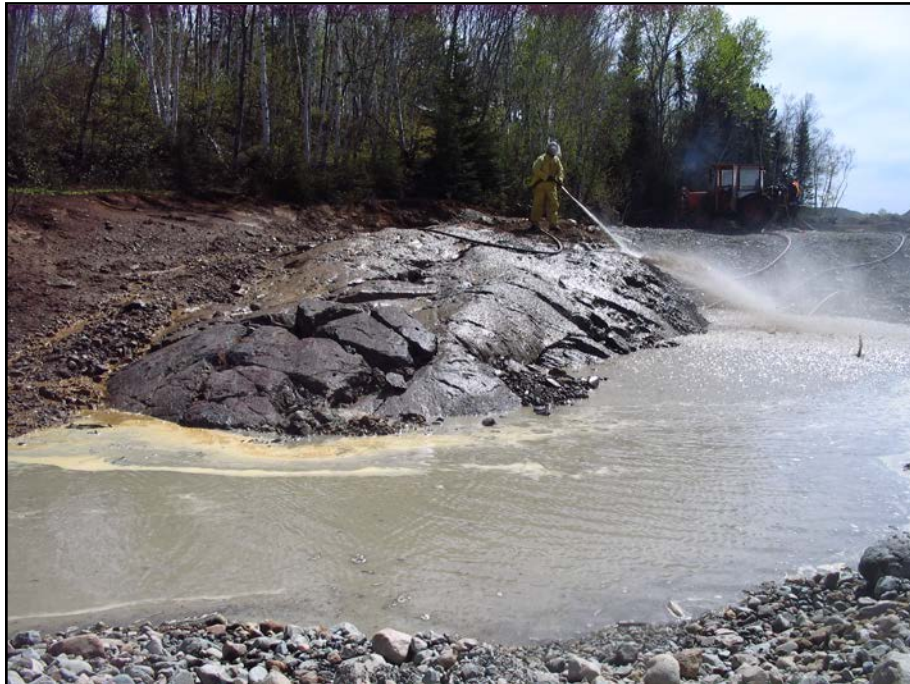
Photo 6.22 : Secteur Intermédiaire – Lavage de roc
