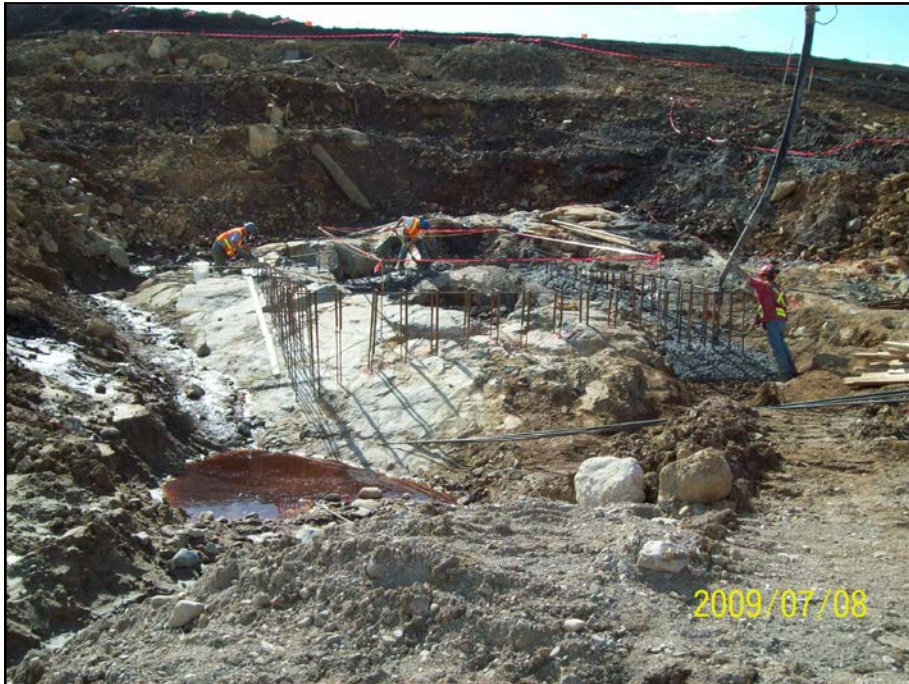
Photo 14.2 : Armature pour muret d'assise des dalles
