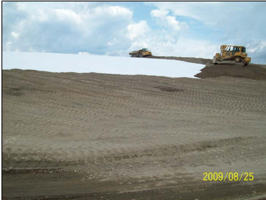
Photo 9.8 : Mise en place du recouvrement final de la cellule
