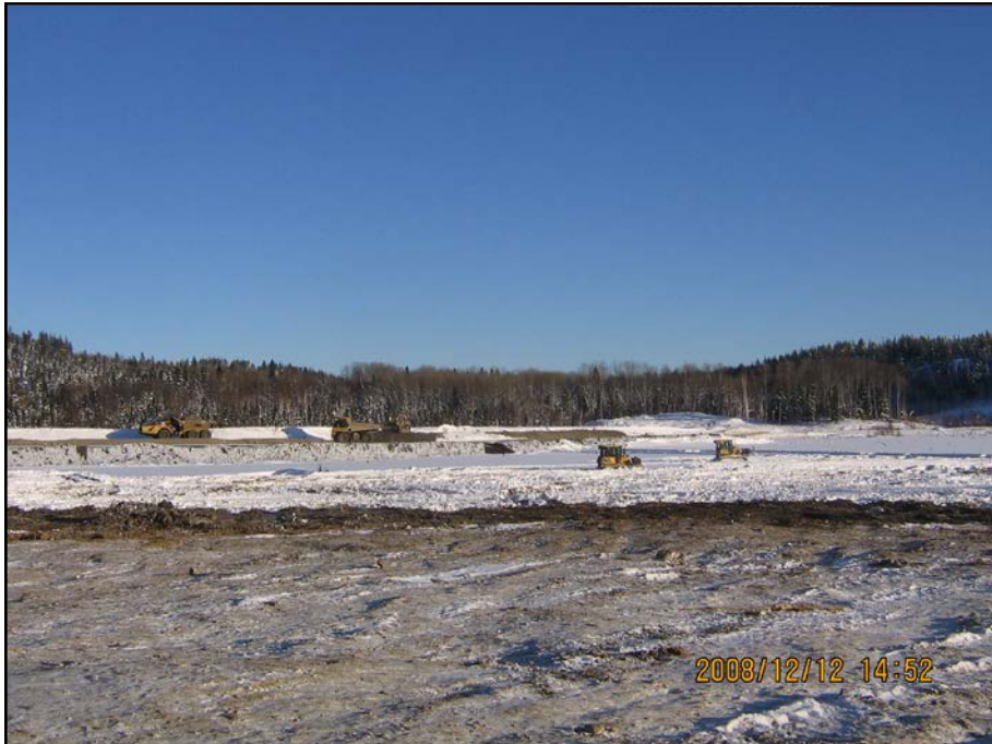
Photo 5.6 : Digue E est – Aménagement berme amont
