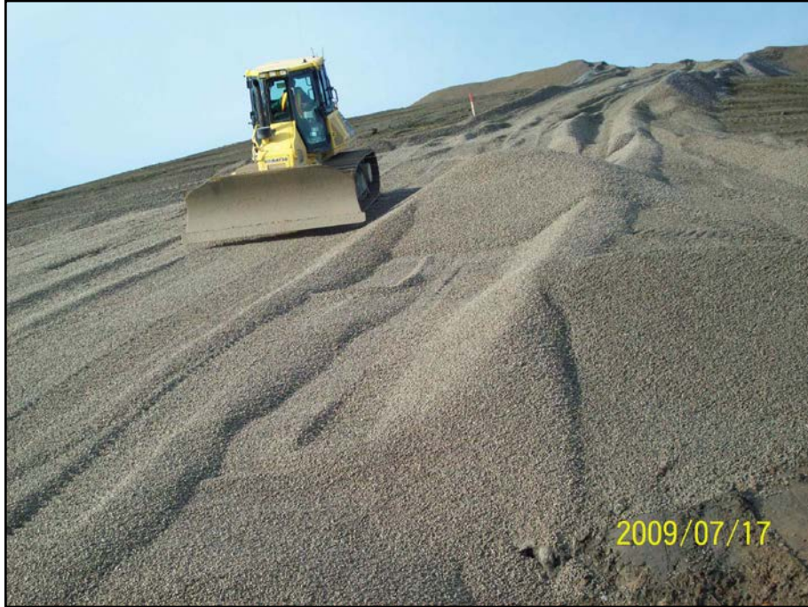
Photo 9.5 : Remblai de gravier 5-20 mm sur résidus
