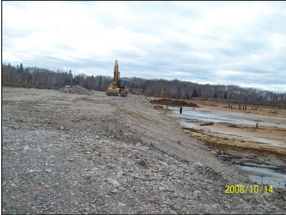
Photo 5.19 : Digue G – Talus aval
