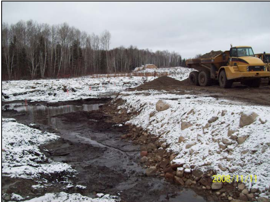
Photo 5.12 : Digue F – Construction de la berme aval
