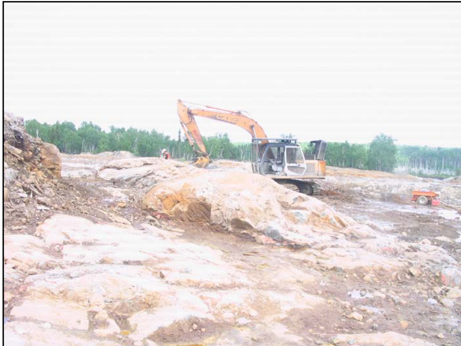
Photo 6.24 : Secteur Sud – Nettoyage du roc avec pelle
