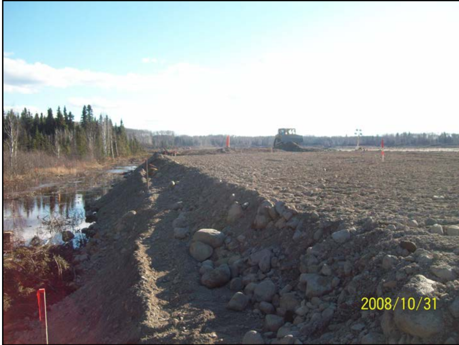
Photo 5.3 : Digue E est – Berme aval
