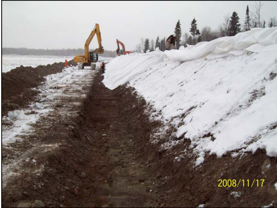
Photo 5.7 : Digue E est – Excavation de la clé d'ancrage pour la géomembrane
