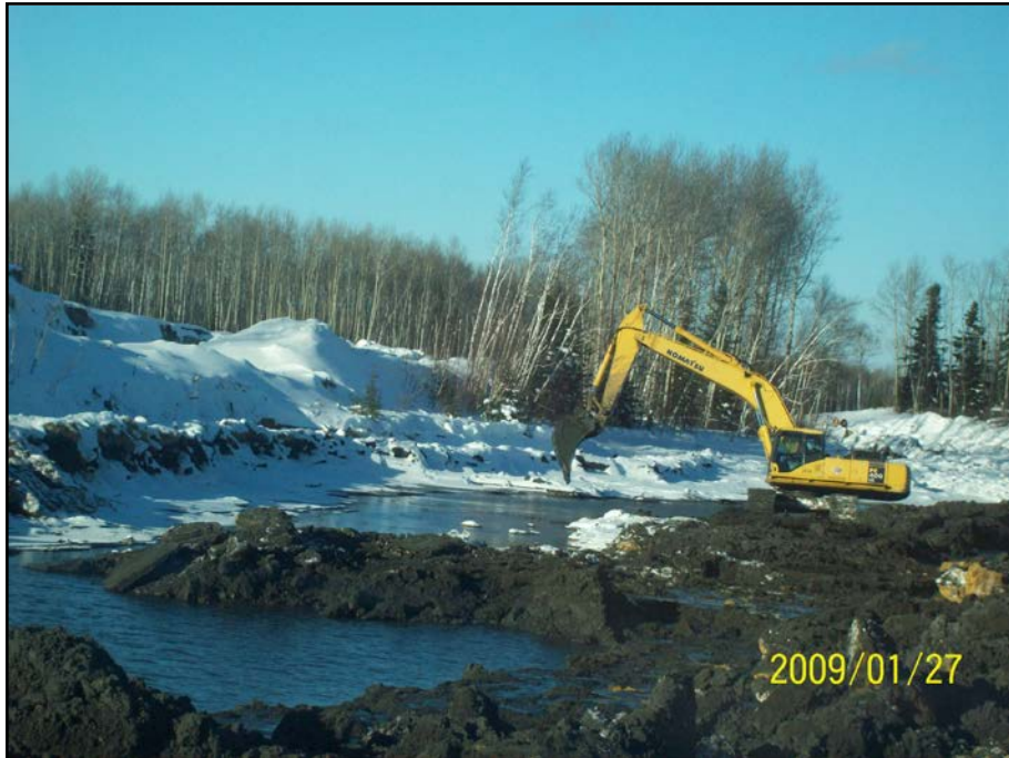
Photo 6.10 : Secteur Intermédiaire – Aménagement de fossés de drainage temporaires
