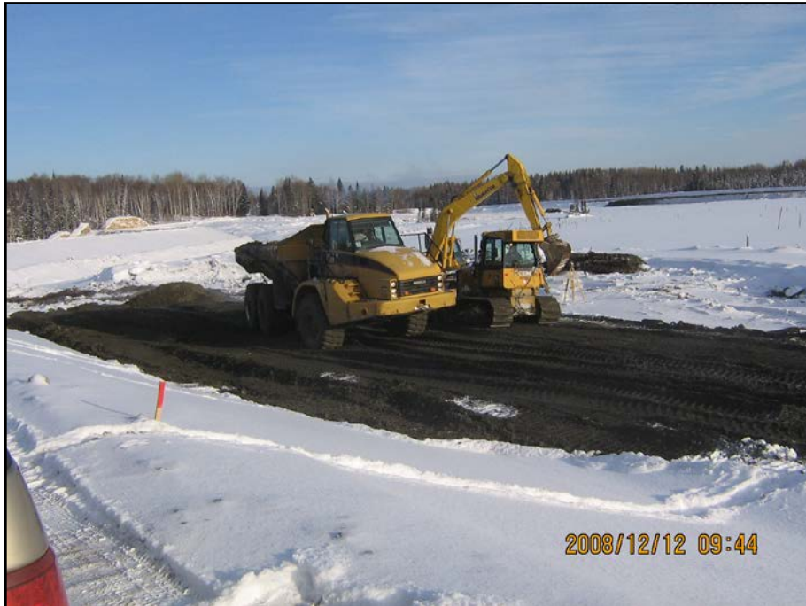
Photo 5.16 : Digue F – Aménagement berme amont avec de résidus
