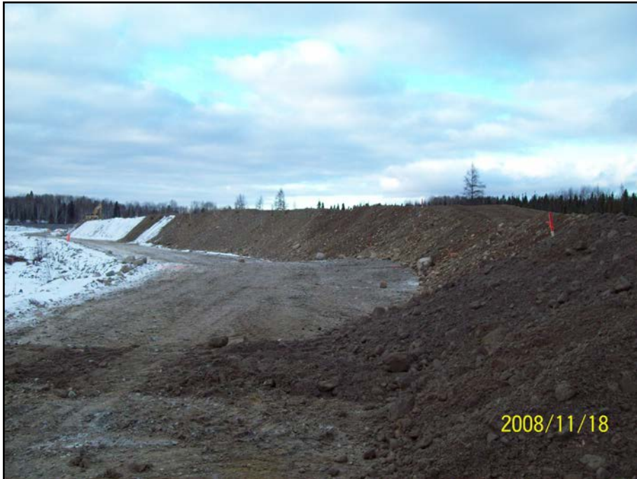
Photo 5.2 : Digue E est – Talus amont
