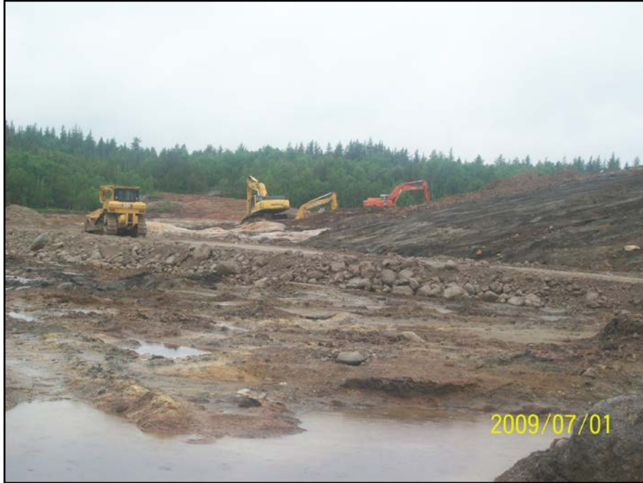
Photo 10.5 : Construction chemin sud
