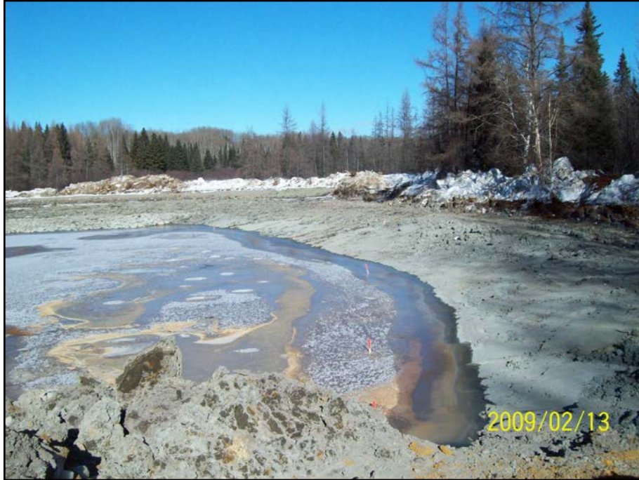
Photo 7.13 : Ruisseau 1 – Bassin de décantation
