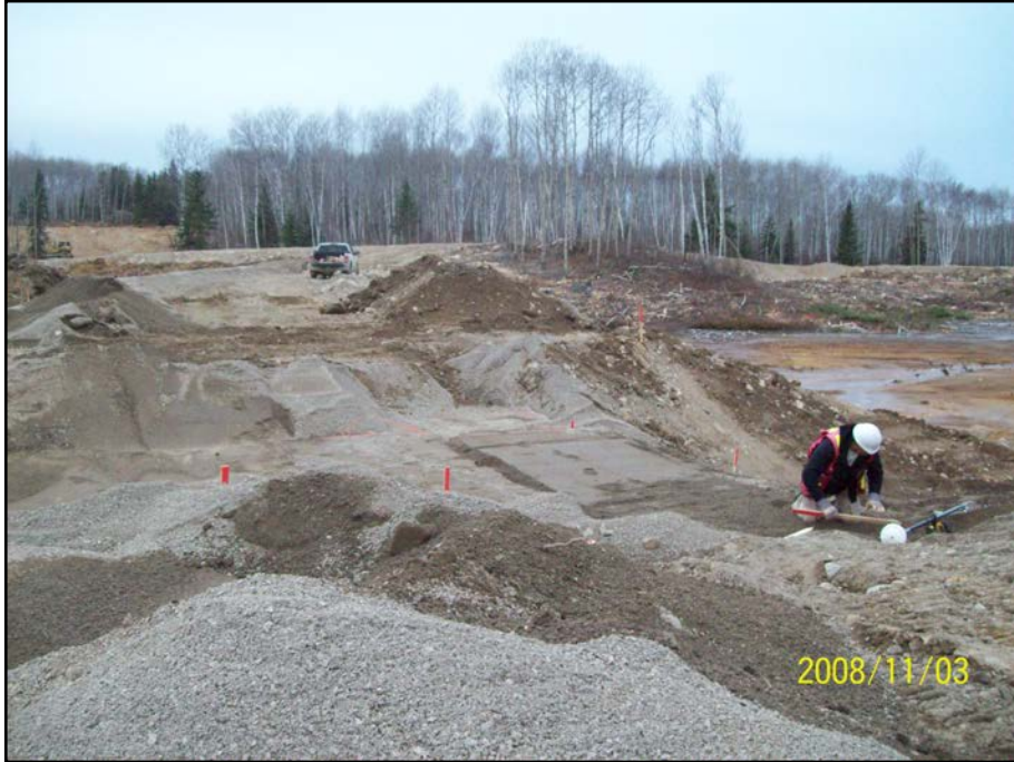
Photo 7.1 : Digue G – Excavation de déversoirs
