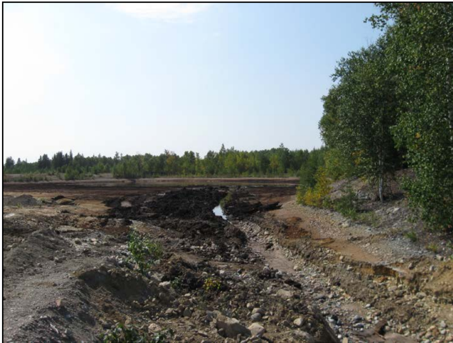
Photo 14.10 : Bassin digue C – brèche nord et fossé temporaire
