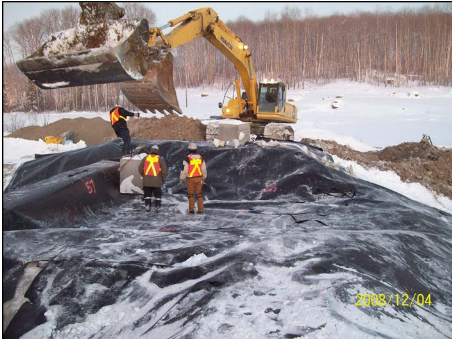
Photo 7.2 : Digue G – Pose des blocs de béton des déversoirs
