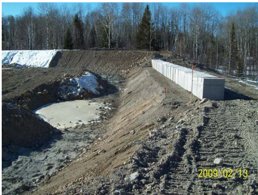
Photo 7.9 : Déversoir Nord – Blocs de béton
