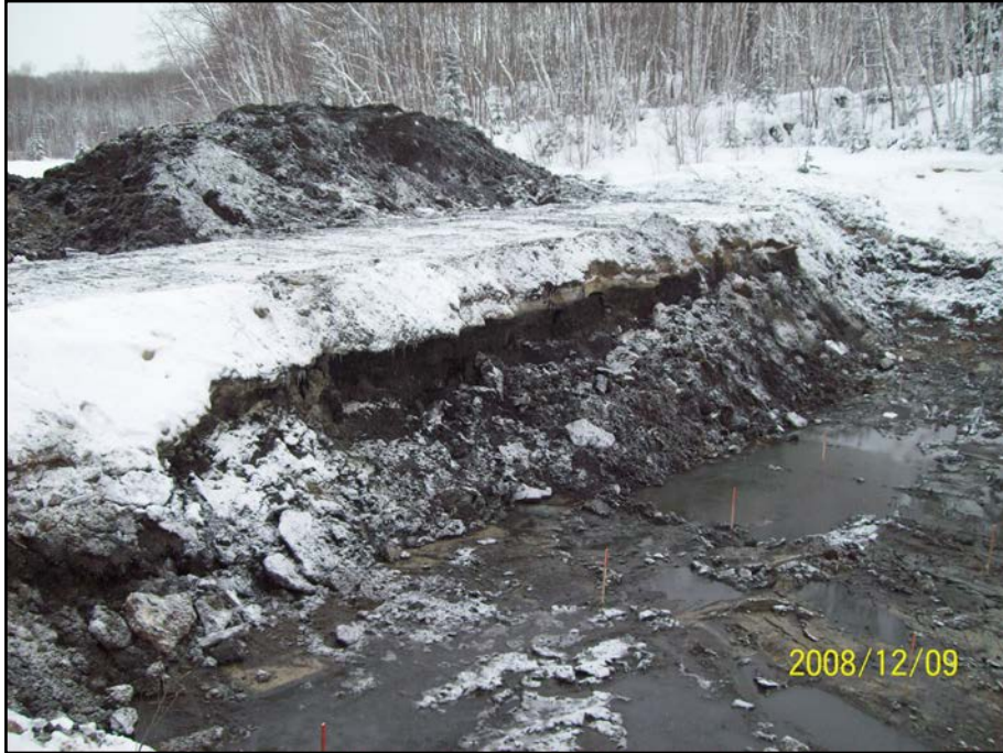
Photo 5.23 : Digue H – Fondation sur argile
