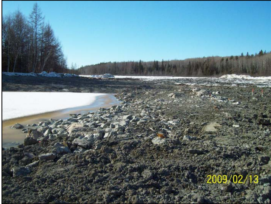
Photo 6.5 : Ruisseau 1 – Surface nettoyée secteur du bassin de décantation
