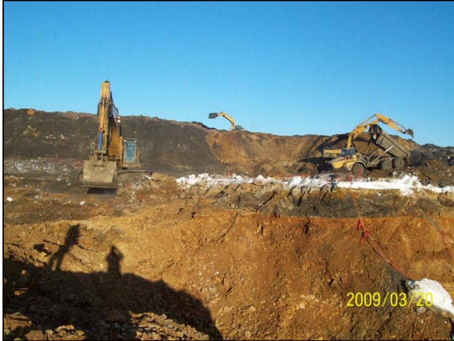
Photo 9.1 : Aménagement de la cellule de confinement
