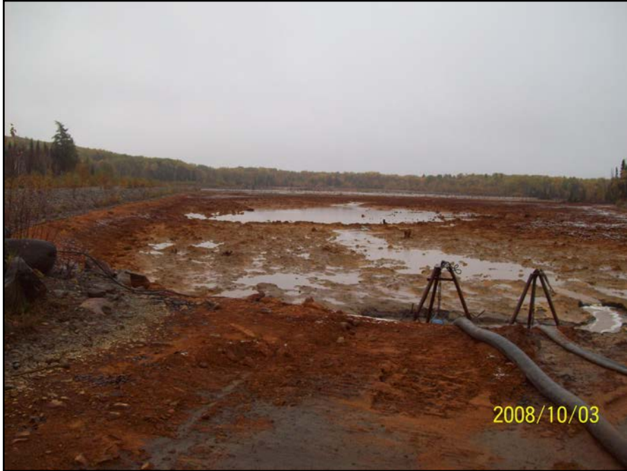
Photo 5.1 : Digue E – Bassin Nord
