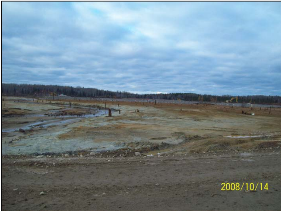
Photo 5.20 : Digue G – Vue générale
