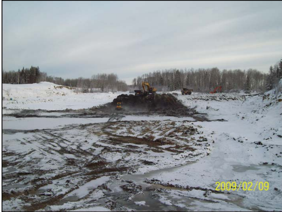
Photo 6.9 : Secteur Intermédiaire – Excavation des résidus sous l'ancien chemin
