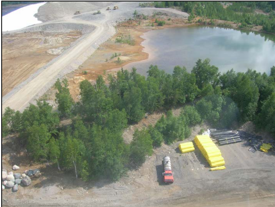
Photo 10.6 : Chemin sud sur digue C existante
