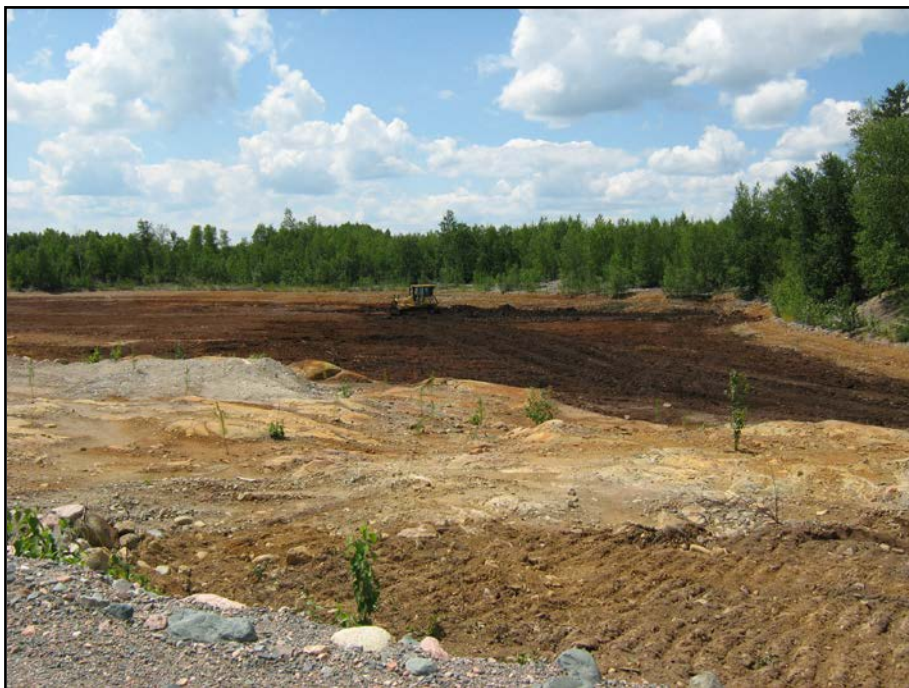
Photo 14.12 : Bassin digue C – profilage du fond
