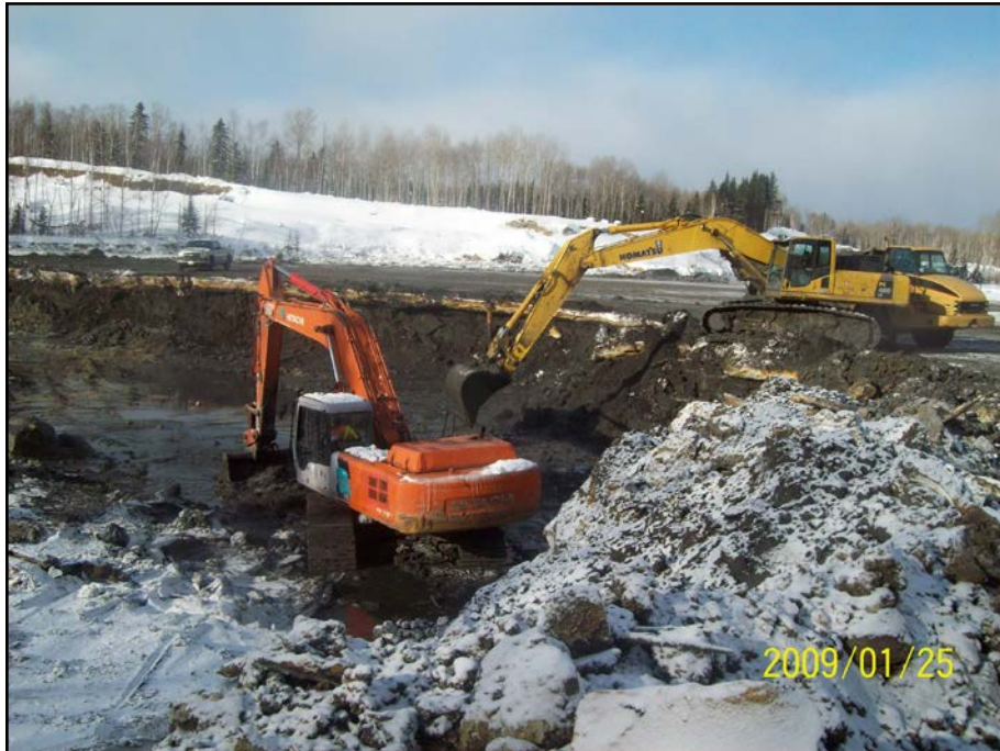
Photo 6.8 : Secteur Intermédiaire – Excavation des résidus
