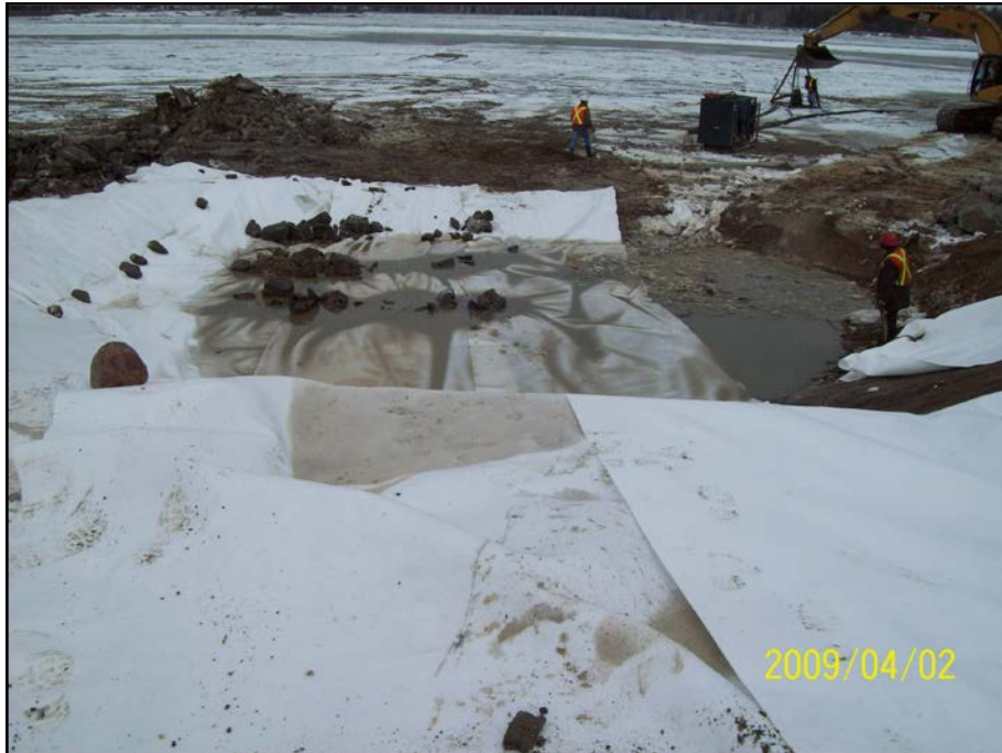
Photo 7.4 : Digue G – Installation du géotextile aux déversoirs
