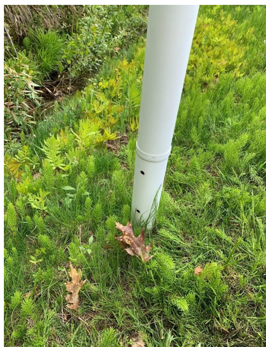
Photo 8 : Tubage protecteur de BE-17 percé de trous.
