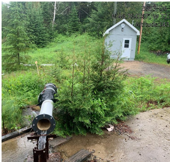
Photo 30 : Prise d'eau potable avec au premier plan un rejet d'eau pompée et en arrière-plan la cabane de pompage (NO-01).
