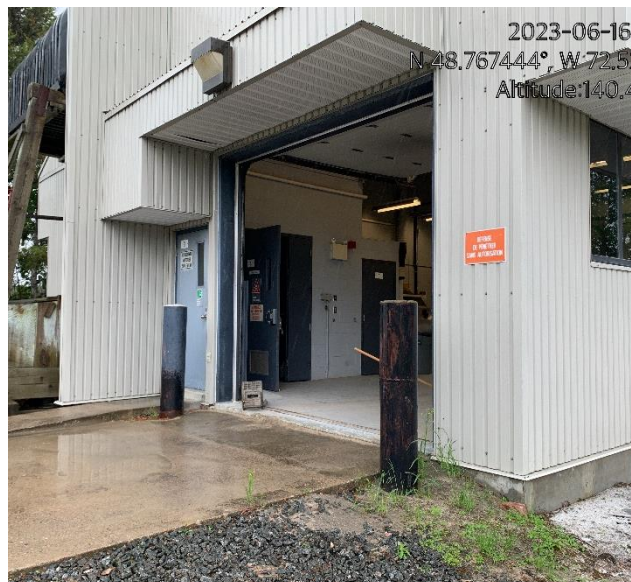
Photo 46 : Détail. Noter que les portes ouvertes facilitent un écoulement accidentel au dehors.
