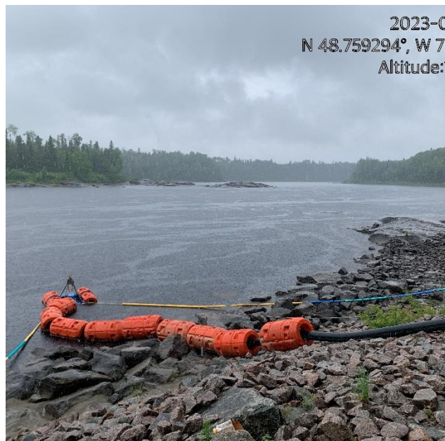
Photo 32 : Prise d'eau dans la rivière Ashuapmushuan pour l'irrigation des cultures.
