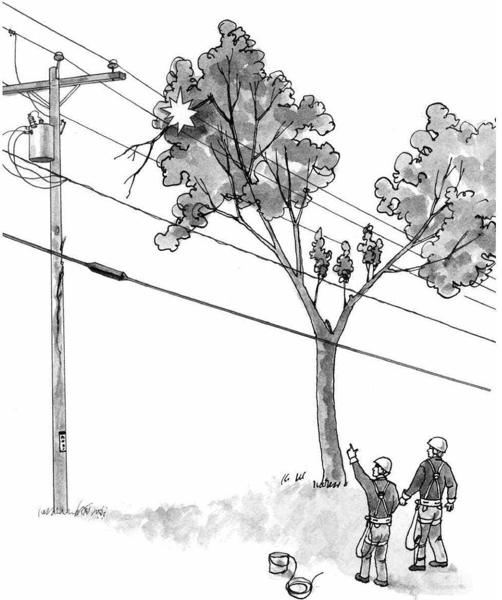
Illustration n° 60 Vérification du lieu de travail lors des travaux d'urgence
