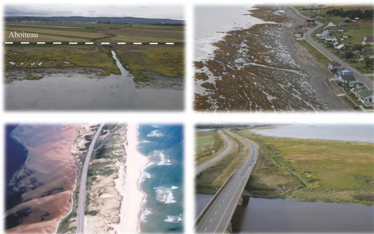
Figure 7. Contraintes artificielles présentes le long du Saint-Laurent. Présence d'aboiteaux près de marais maritimes, Kamouraska (en haut à gauche), terrasses de plage et plages à proximité de bâtiments et de la route 132, Sainte-Flavie (en haut à droite), route 199 sur un cordon-tombolo, Îles-de-la-Madeleine (en bas à gauche) et autoroute 20 près du marais maritime, Rivière-du-Loup (en bas à droite).
