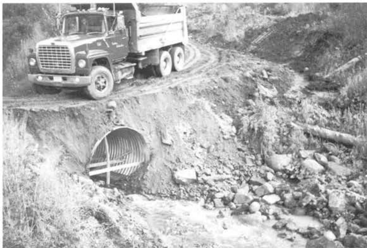
Ponceaux non consolidés et instables qui seront obstrués à court terme.
