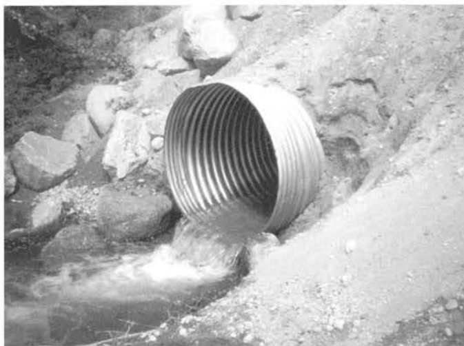
Ponceaux non consolidés et instables qui seront obstrués à court terme.
