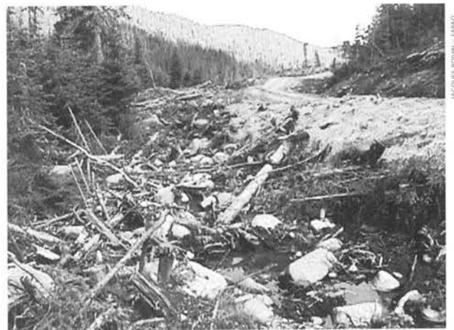
Chemin forestier sans réseau de drainage et empiétant sur un cours d'eau.
