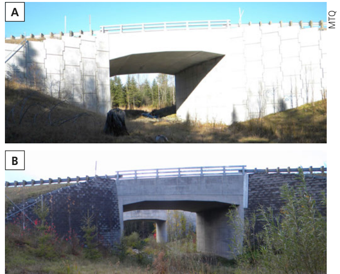
Figure 5. Photo illustrant l'éblouissement causé par le revêtement poli des murs d'ailes du premier portique du passage du ruisseau Doyon (A) et photo du revêtement en pierres fragmentées des murs d'aile du second portique du passage du ruisseau Doyon (B).
