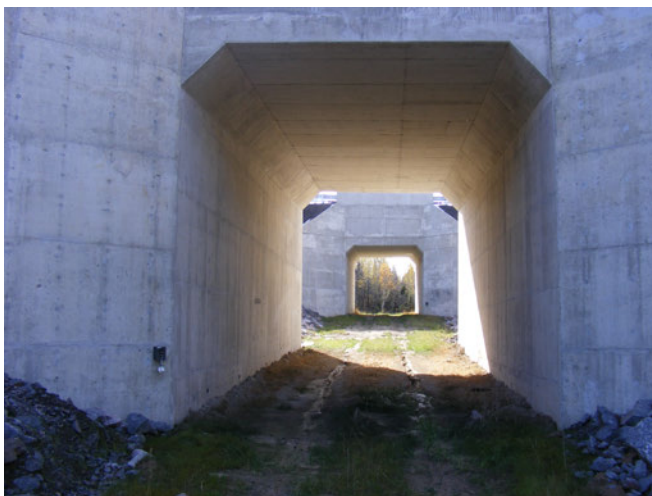
Figure 3. Le passage faunique inférieur (écoduc) de Burwash comprend 2 ponceaux carrés identiques et une ouverture médiane clôturée.
