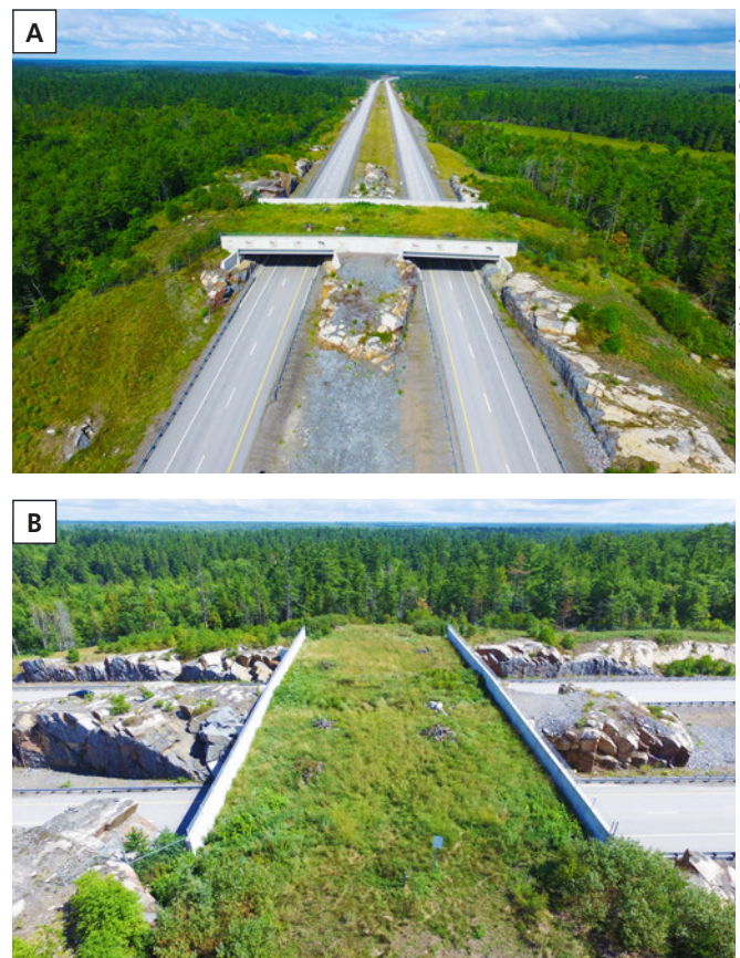
Figure 2. Passage faunique supérieur (écopont) de Burwash : a) implantation au niveau d'un point de concentration des collisions véhicules-faune, afin de réduire les impacts de la construction de l'autoroute sur le corridor de déplacement de la faune; b) plantation d'espèces indigènes d'arbres, d'arbustes et d'herbacées sur le tablier de l'écopont.
