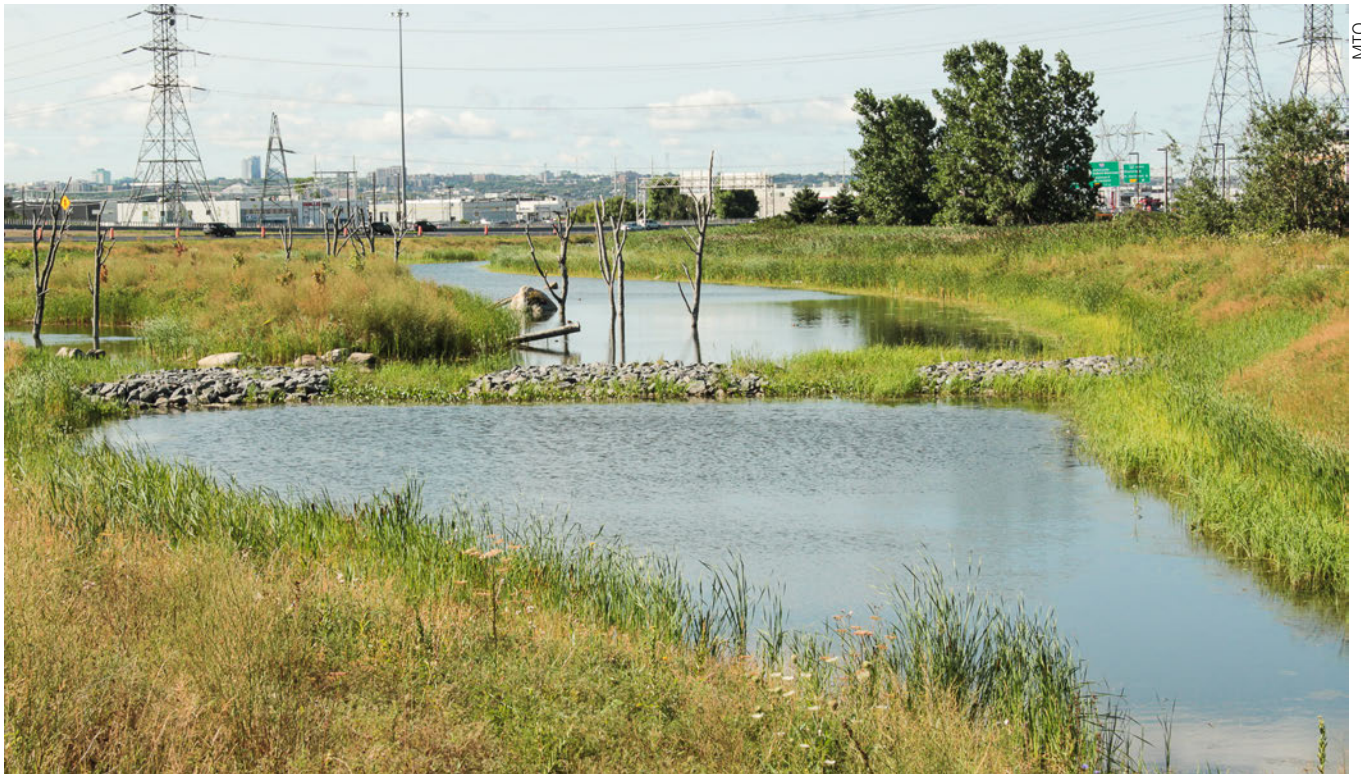
Figure 3. Au premier plan : cellule de prédécantation située en amont du bassin de rétention de l'échangeur des autoroutes 40 et 73 situé dans la ville de Québec. Au second plan : vue d'ensemble du bassin de rétention.
