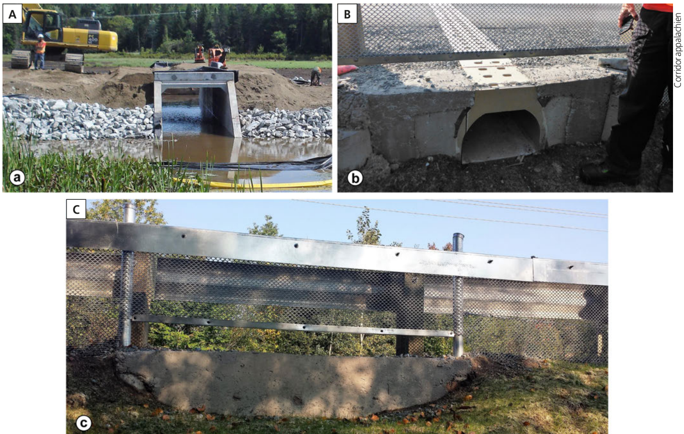
Figure 2. Photographies du passage à tortues de la route 245 à Bolton-Est: a) ponceau préfabriqué en béton; b) tunnel préfabriqué en béton polymère; c) clôture de déviation et échappatoire.
