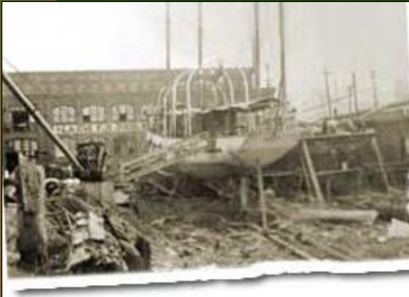
Chantier à l'arrière de l'usine
