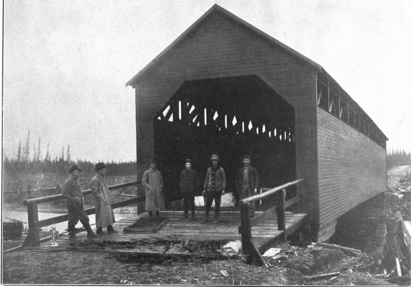
PREMIER PONT CONSTRUIT DANS L'ABITIBI.—Ce pont est situé sur le ruisseau "Peter Brown", dans le 6ème rang du canton Figury.—Longueur 112 pieds
