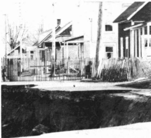
Aspect des travaux correctifs exécutés par le Service de géotechnique et la Direction générale des Eaux sur les lieux du glissement de terrain survenu le 4 novembre 1974 à Yamaska.
