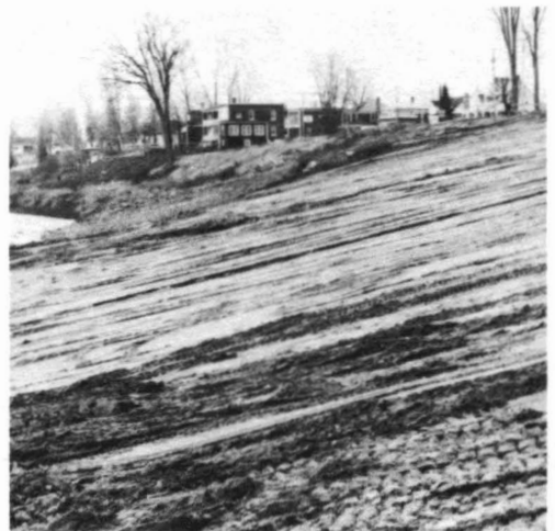
Affaissement d'une partie d'une rue survenu le 10 octobre 1975 à Louiseville.
