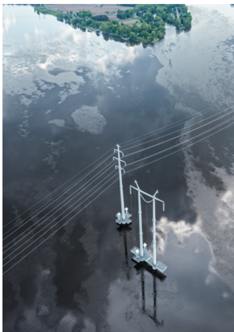
Section d'une ligne du projet de la Chamouchouane–Bout-de-l'Île traversant la rivière des Prairies, au nord-est de Montréal.
